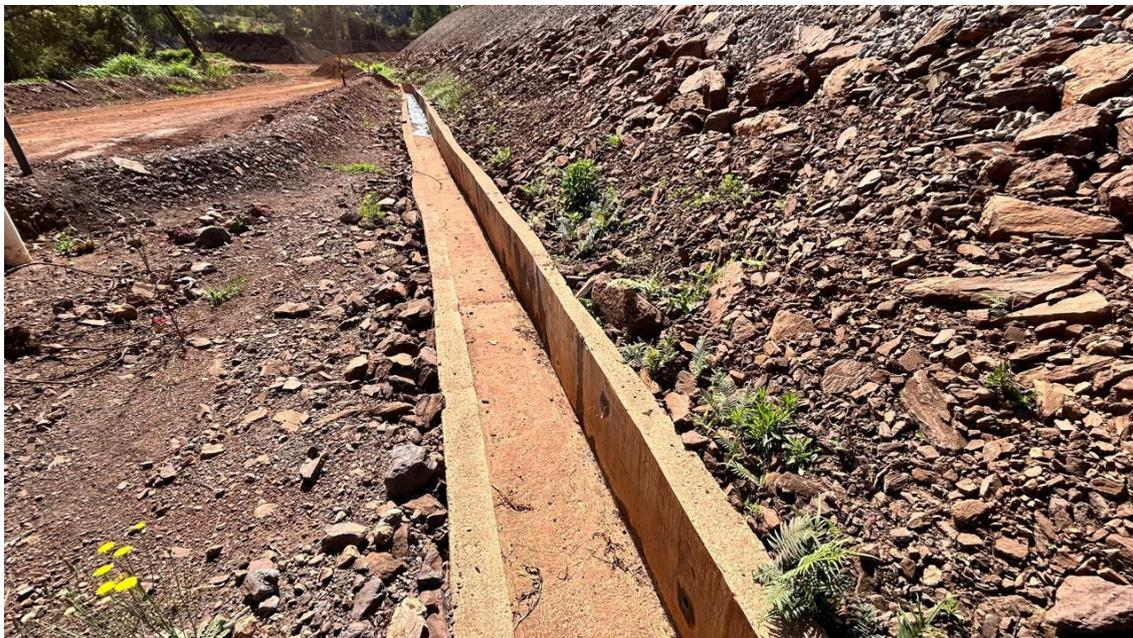
**Figura 84 – Região de saída do sistema de drenagem interna da barragem e canaletas de drenagem no pé da barragem.**
