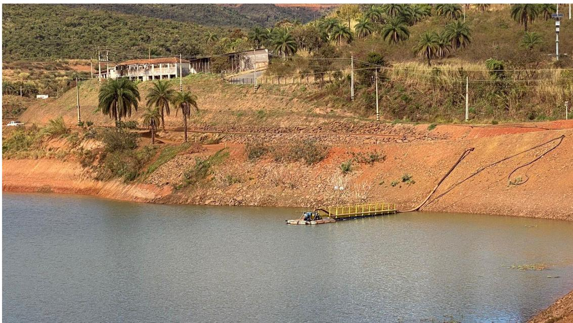
**Figura 63 – Reservatório da Barragem B1 com sistema de bombeamento instalado.**
