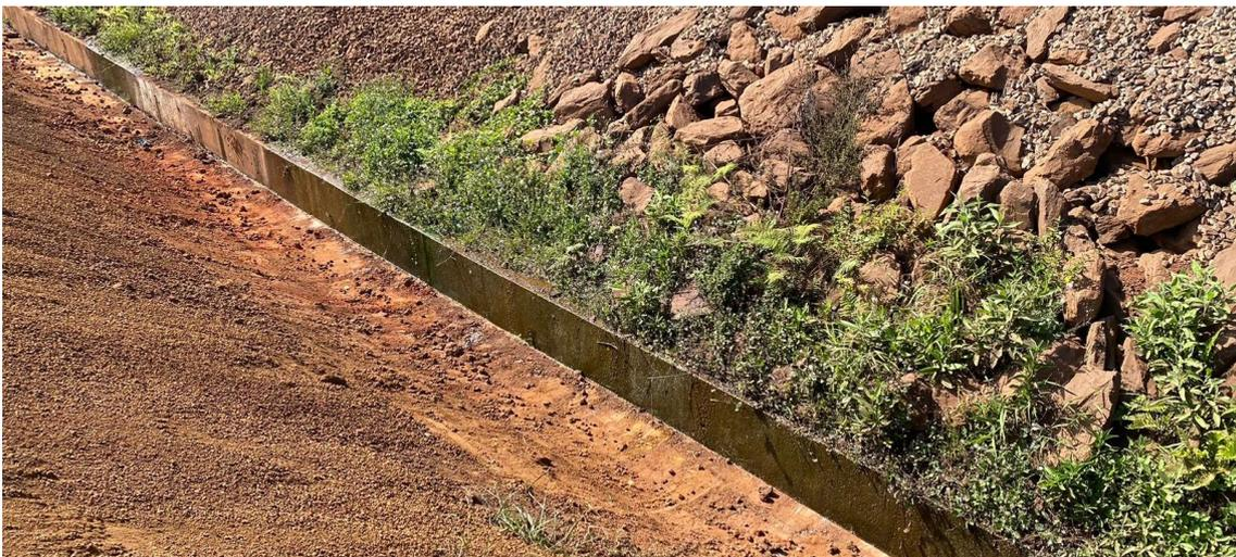
**Figura 81 – Canaleta de drenagem no pé da barragem com fluxo de água límpida.**
