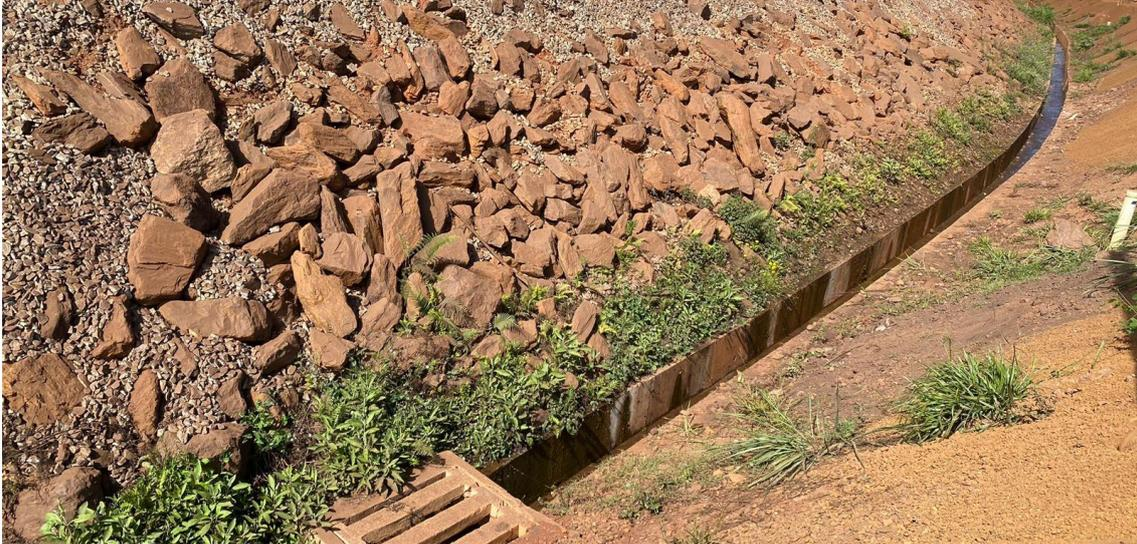
**Figura 82 – Canaleta de drenagem no pé da barragem com fluxo de água límpida.**
