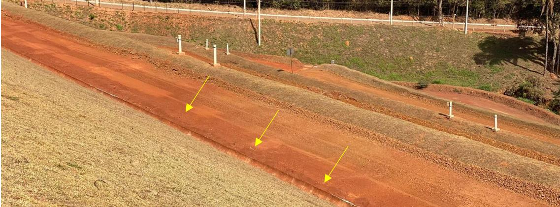
**Figura 80 – Taludes e bermas de jusante, com destaque para as canaletas de drenagem superficial instaladas.**
