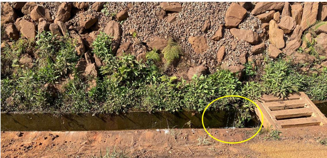
**Figura 83 – Canaleta de drenagem no pé da barragem com fluxo de água límpida.**
