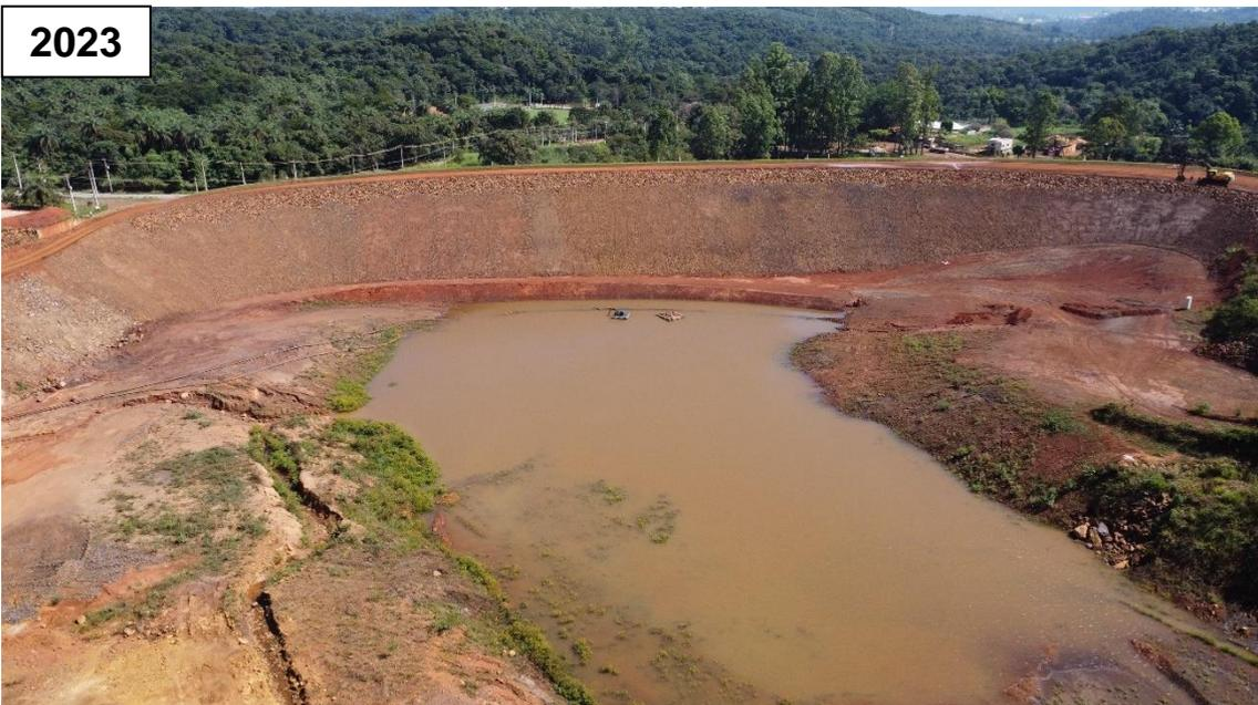
**Figura 51 – Detalhe do reservatório e talude de montante da Barragem B1 – maio/2023.**
