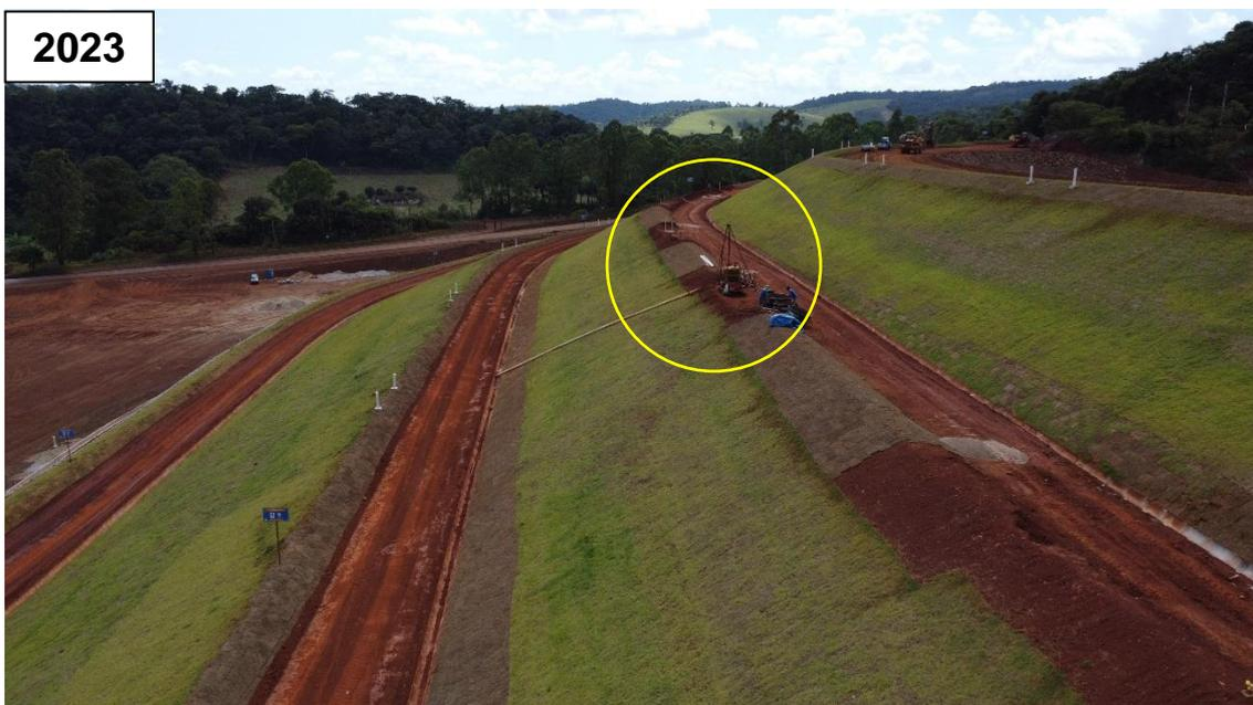
**Figura 47 - Vista a partir da ombreira esquerda dos taludes e bermas de jusante da Barragem B1 – destaque para sondas finalizando a instalação da instrumentação – abril/2023.**
