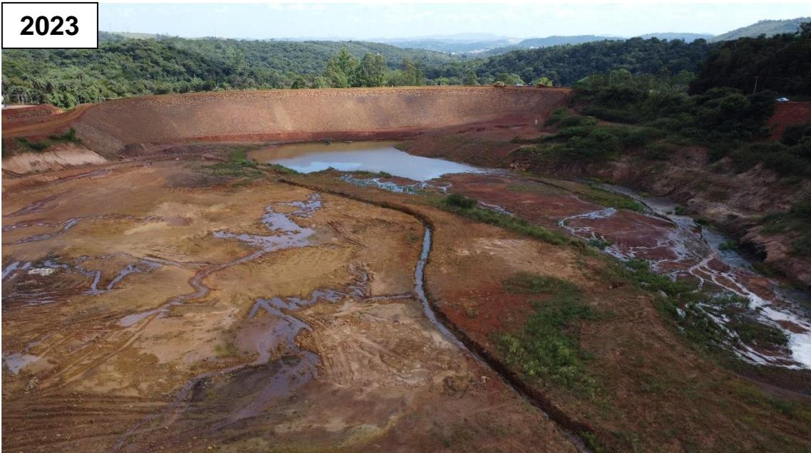
**Figura 45 - Detalhe do reservatório e talude de montante da Barragem B1 – abril/2023.**
