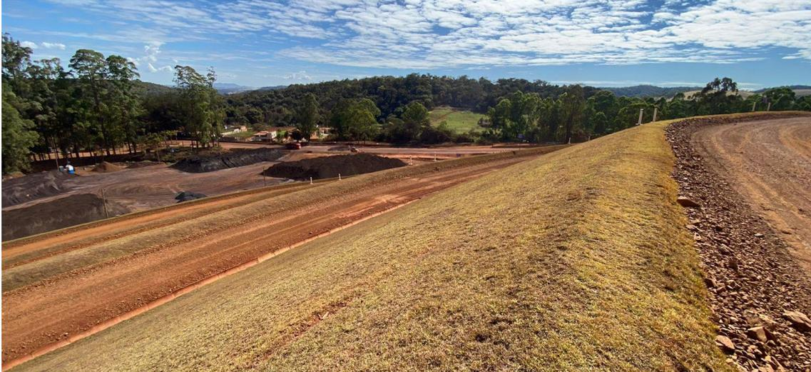
**Figura 69 – Taludes e bermas de jusante da barragem.**
