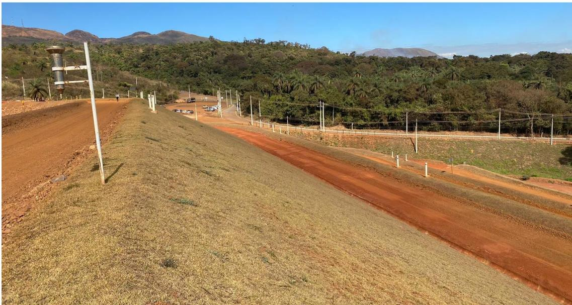
**Figura 68 – Taludes e bermas de jusante da barragem.**
