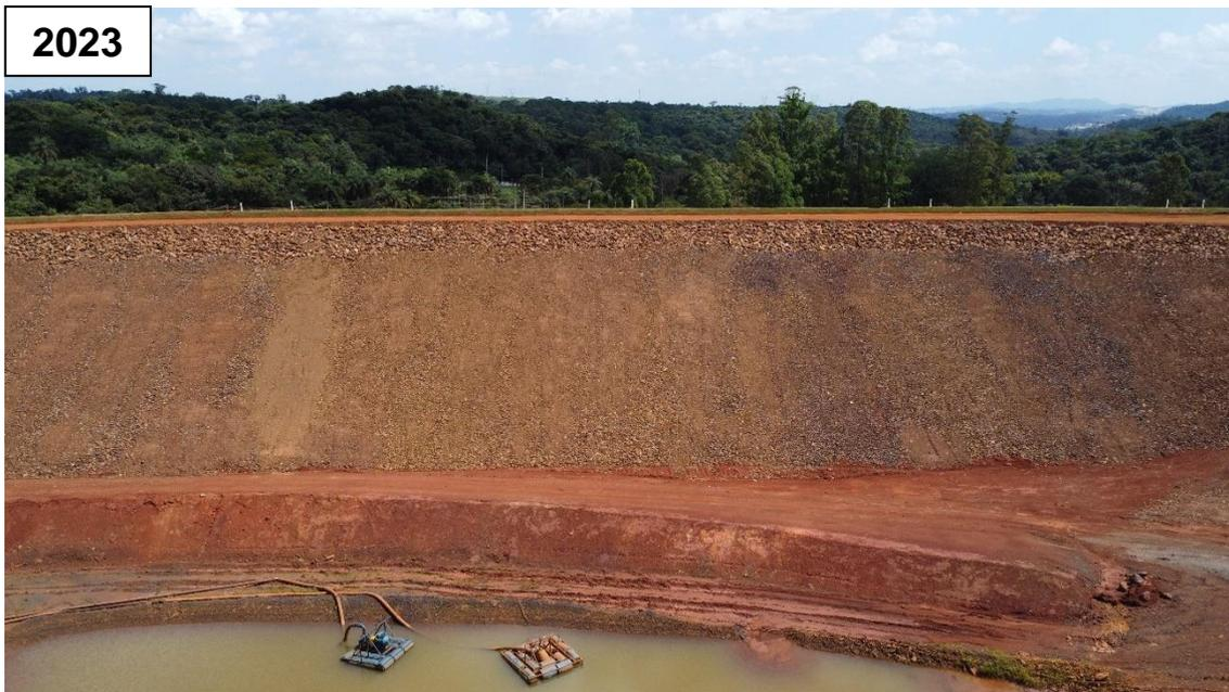
**Figura 46 – Detalhe do talude de montante e das bombas no interior do reservatório da Barragem B1 – abril/2023.**
