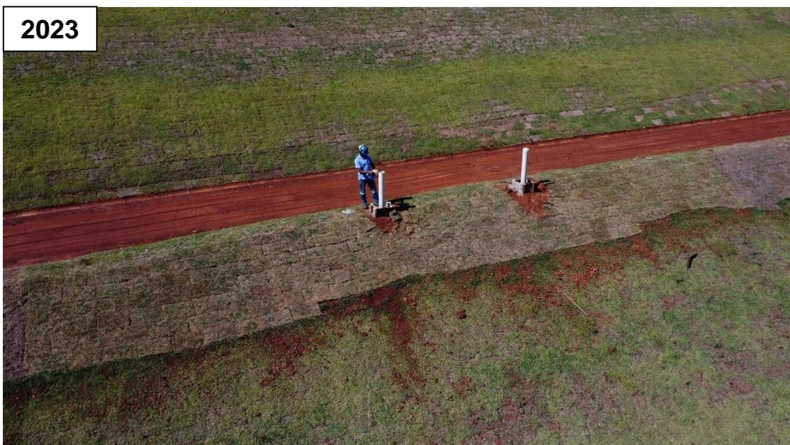
**Figura 55 – Detalhe da berma e taludes com operador executando trabalhos de manutenção e monitoramentos nos instrumentos instalados na Barragem B1 – maio/2023.**
