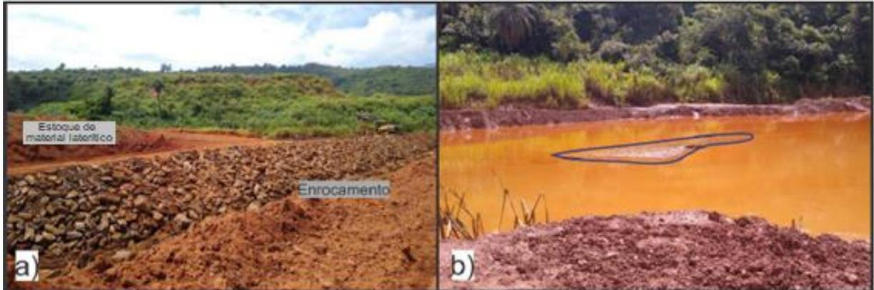
**Figura 11 – Coberturas antrópicas. a) Canal enrocado para desvio e de fluxo de drenagem da Barragem B1. Pilha pulmão de material laterítico ao fundo. b) Bancos de areais depositados a montante do reservatório da Barragem B1 e que estão sendo retirados e depositados em pilhas no empreendimento.**
