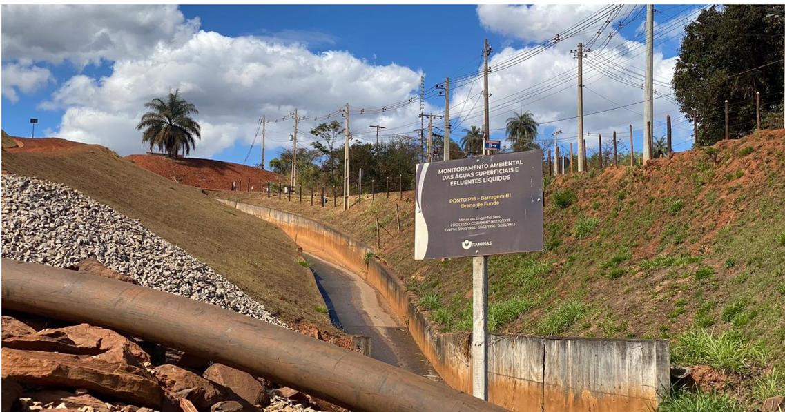
**Figura 71 – Canal extravasor – Ombreira esquerda.**
