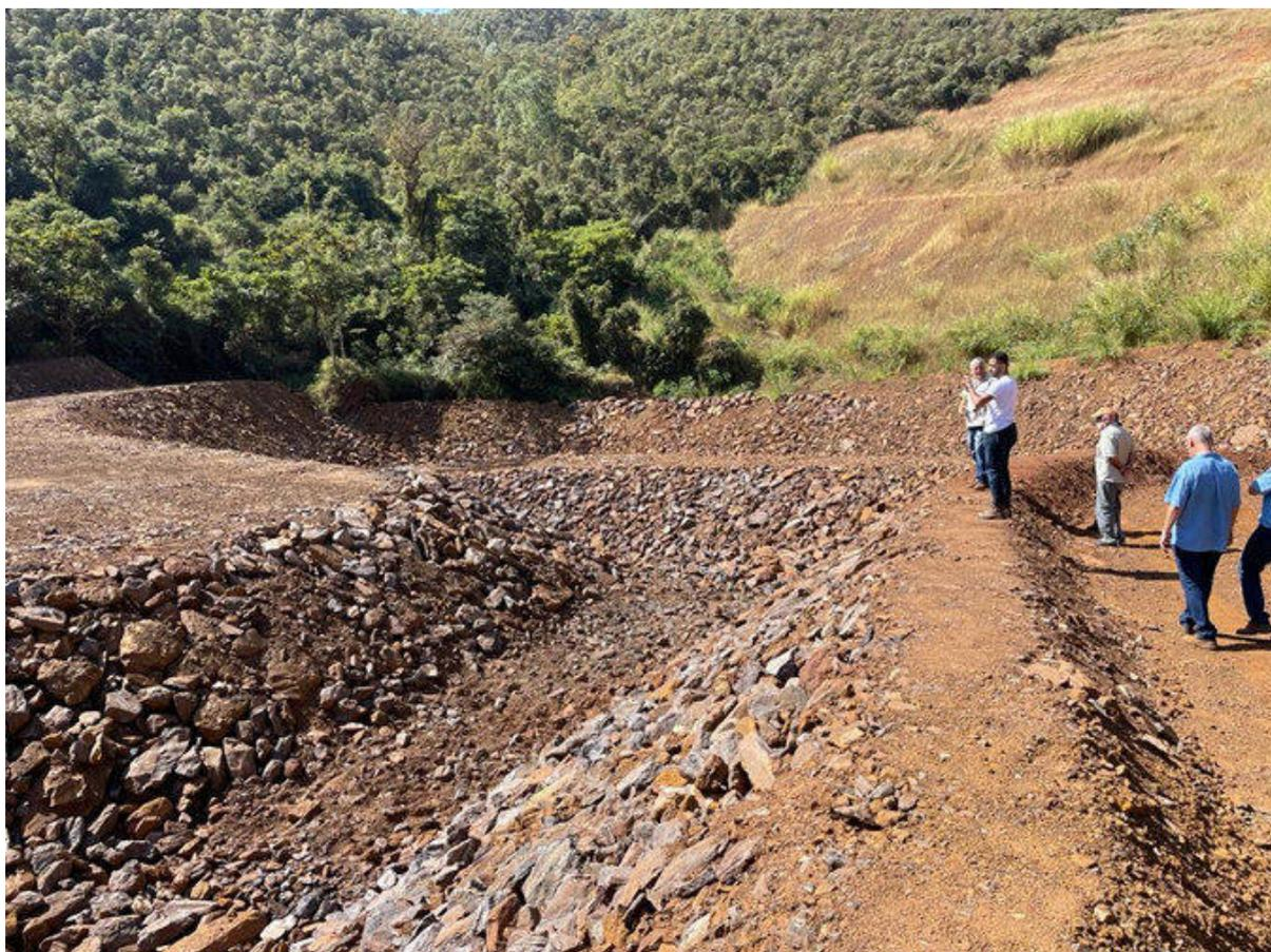
Foto 3 – Dique de contenção de sedimentos de pé de pilha. Fonte: Vistoria da ANM no dia 11/07/2027.
