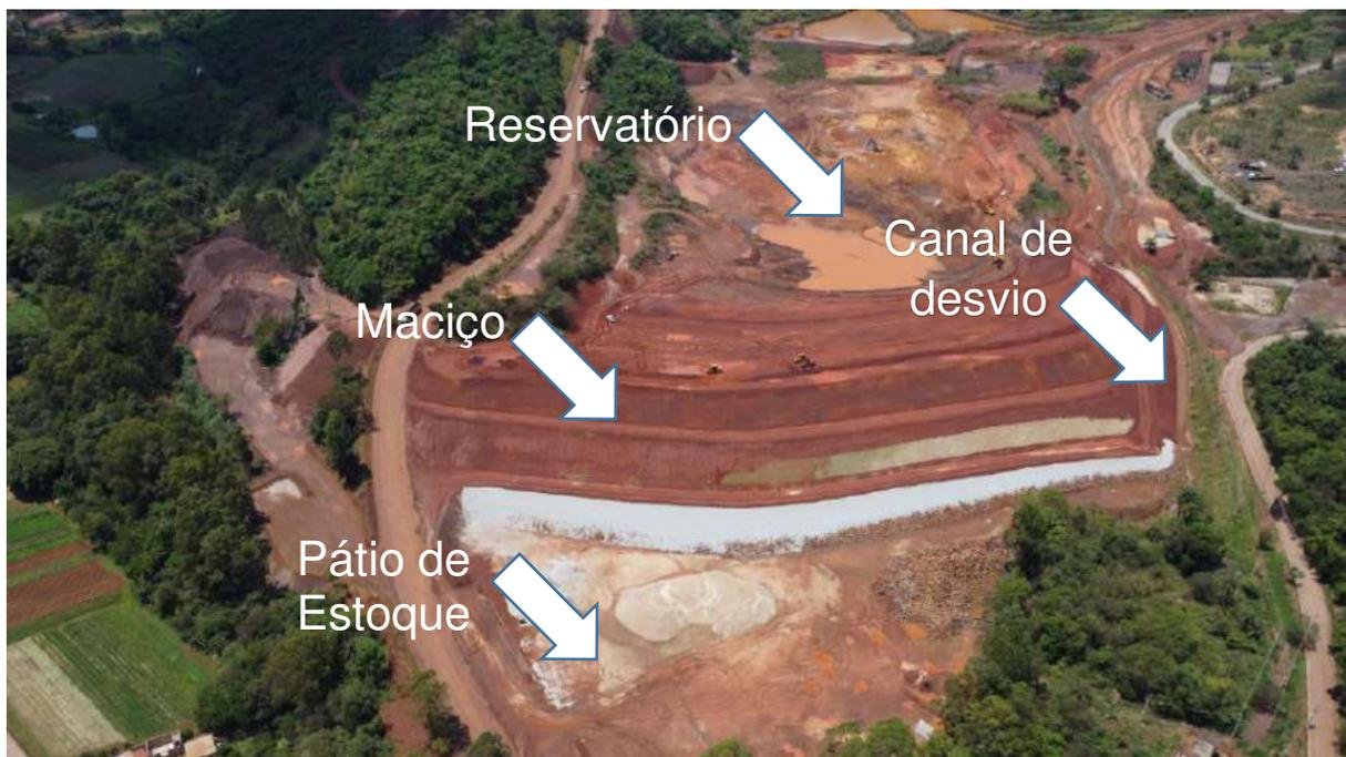
**Figura 1 - Vista geral da Barragem B1 - Em destaque o canal de desvio e reservatório**
