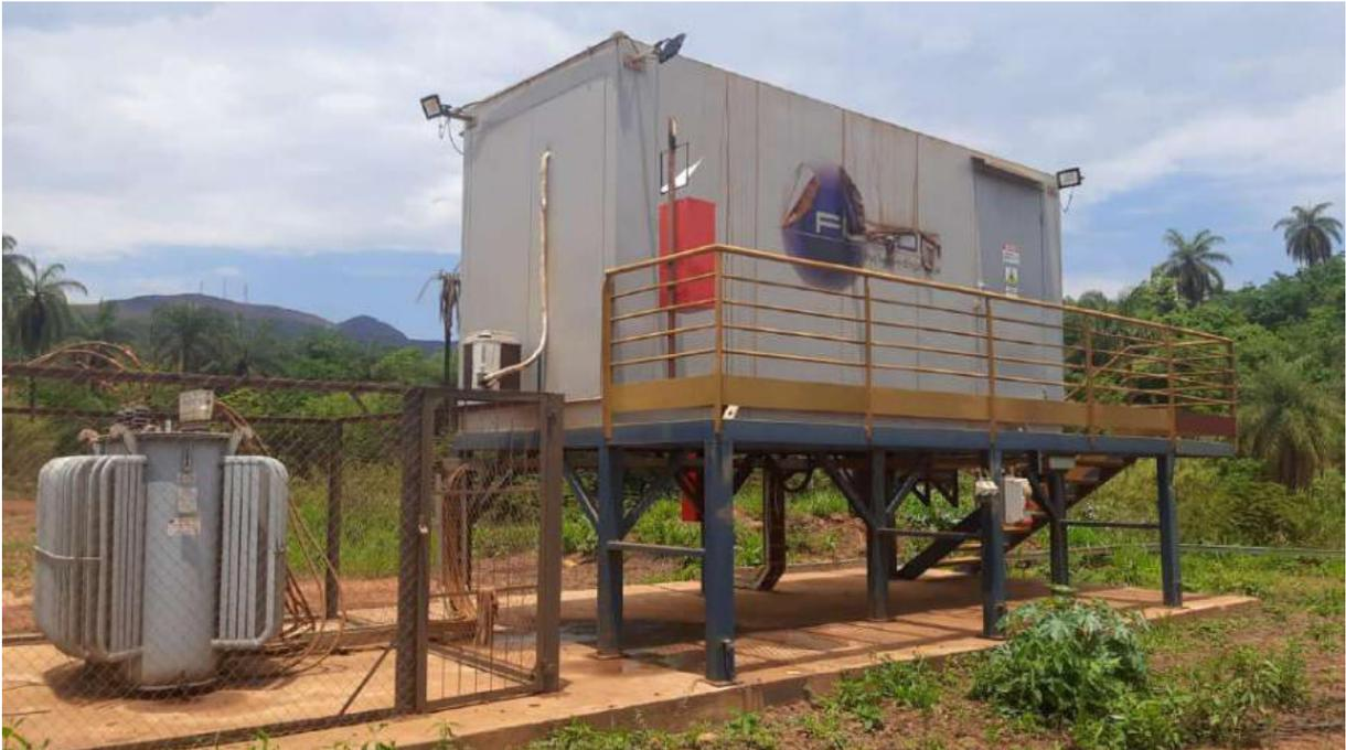
**Foto 5 – Central de energia e automação do sistema de bombeamento**
