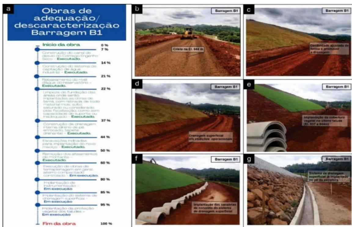
**Figura 12 - a) Sequenciamento e status das obras de adequação - Barragem B1; b) Crista na El. 844 m, conforme cota final de projeto; c) Detalhe para os ajustes de declividade ao longo da berm; d) Drenagem superficial em condição operacional; e) Implantação da cobertura vegetal ao longo do último talude; f) Detalhe para as canaletas de concreto que serão implantadas no sistema de drenagem superficial; g) Sistema de drenagem superficial já implantado no pé da estrutura.**
