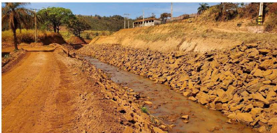
Figura 3 - Vista parcial do canal de desvio.
