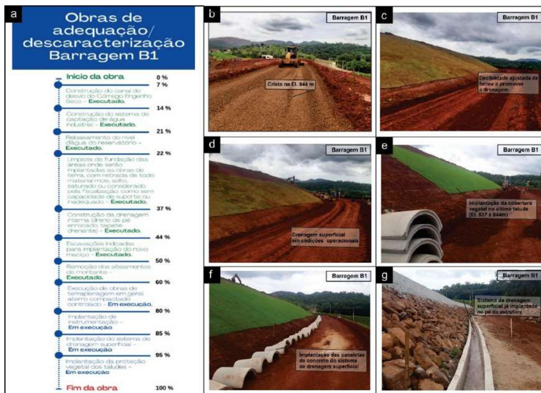
Figura 11 - a) Sequenciamento e status das obras de adequação - Barragem B1; b) Crista na El. 844 m, conforme cota final de projeto; c) Detalhe para os ajustes de declividade ao longo da berma; d) Drenagem superficial em condição operacional; e) Implantação da cobertura vegetal ao longo do último talude; f) Detalhe para as canaletas de concreto que serão implantadas no sistema de drenagem superficial; g) Sistema de drenagem superficial já implantado no pé da estrutura.
