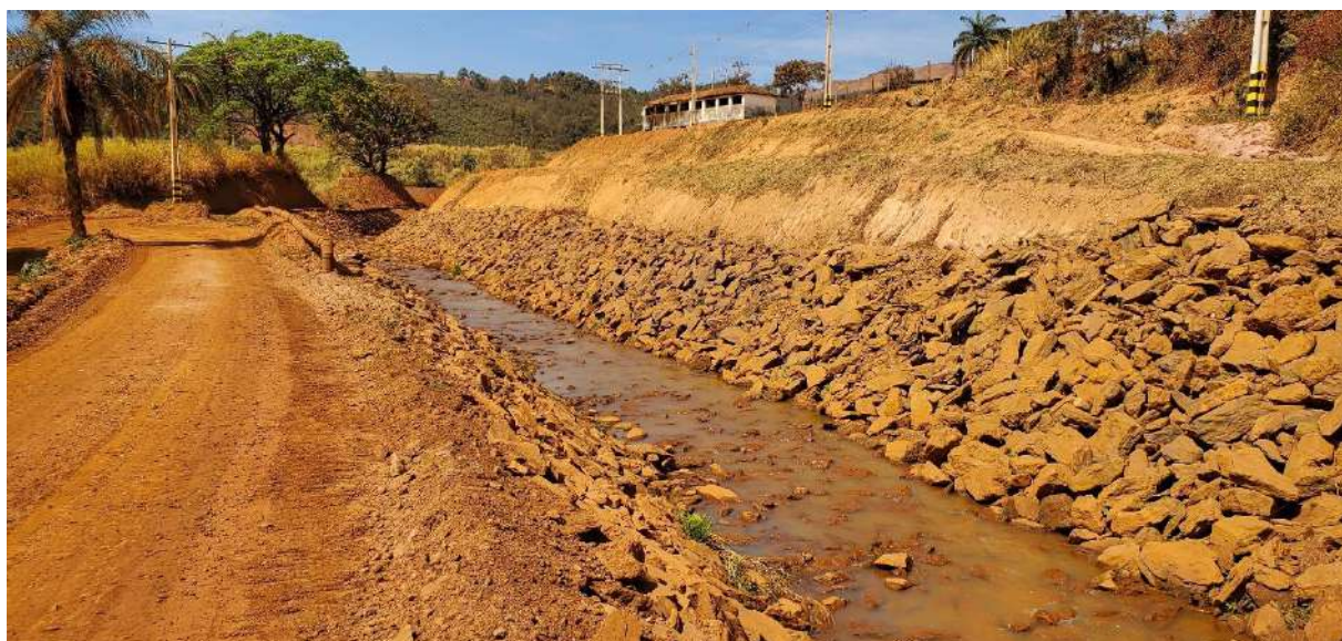
Figura 2 - Vista parcial do canal de desvio
