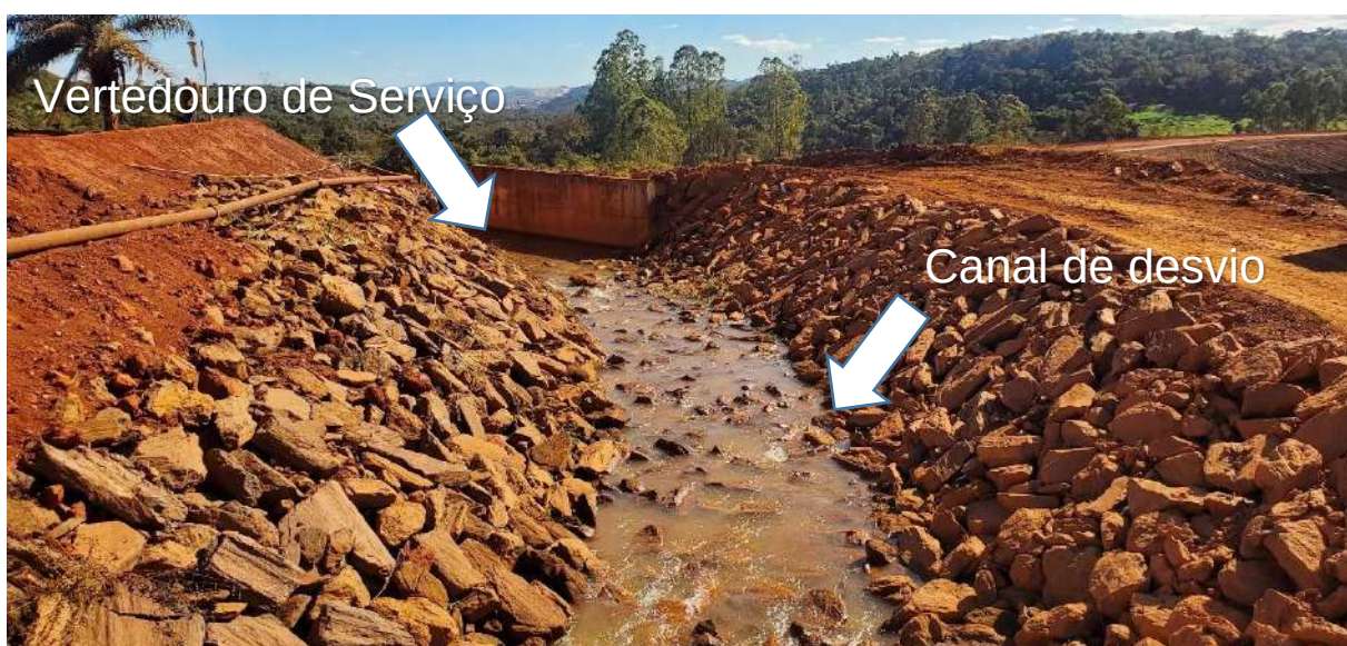
Figura 4 - Destaque do emboque do canal de desvio com o vertedouro de serviço
