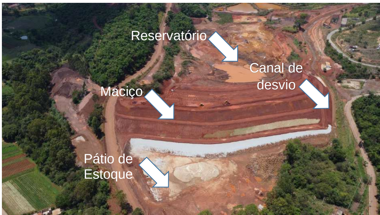
Figura 1 - Vista geral da Barragem B1 - Em destaque o canal de desvio e reservatório
