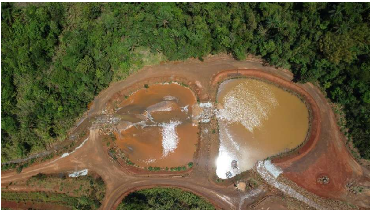
Foto 7 - Bacias de Captação de Água Industrial
