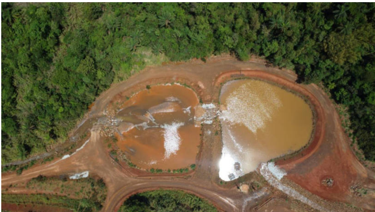
Foto 7 - Bacias de Captação de Água Industrial
