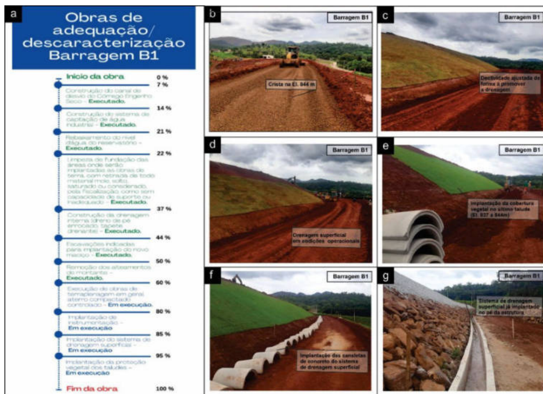
Figura 11 - a) Sequenciamento e status das obras de adequação - Barragem B1; b) Crista na El. 844 m, conforme cota final de projeto; c) Detalhe para os ajustes de declividade ao longo da berm; d) Drenagem superficial em condição operacional; e) Implantação da cobertura vegetal ao longo do último talude; f) Detalhe para as canaletas de concreto que serão implantadas no sistema de drenagem superficial; g) Sistema de drenagem superficial já implantado no pé da estrutura.
