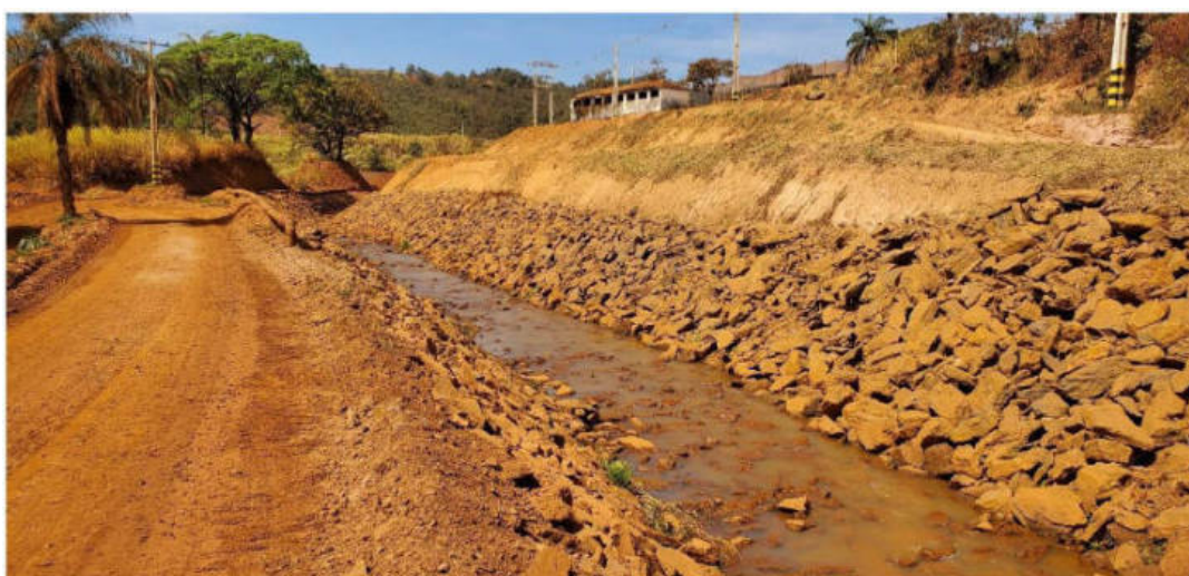
Figura 3 - Vista parcial do canal de desvio.
