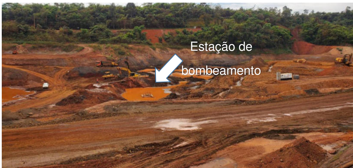
Figura 3 - Vista do reservatório com destaque para estação de bombeamento
