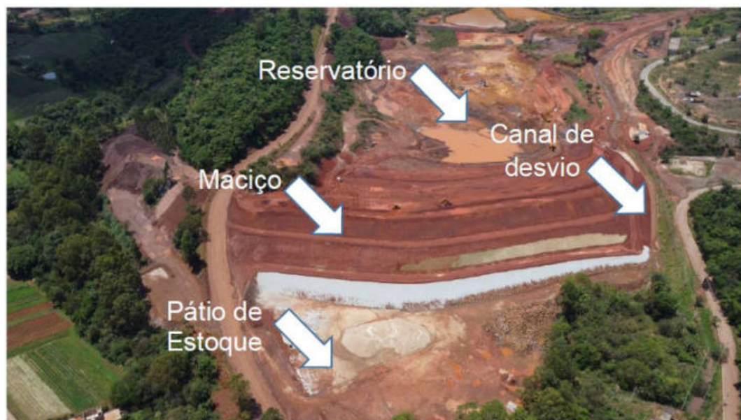
Figura 2 - Vista geral da Barragem B1 - Em destaque o canal de desvio e reservatório.
