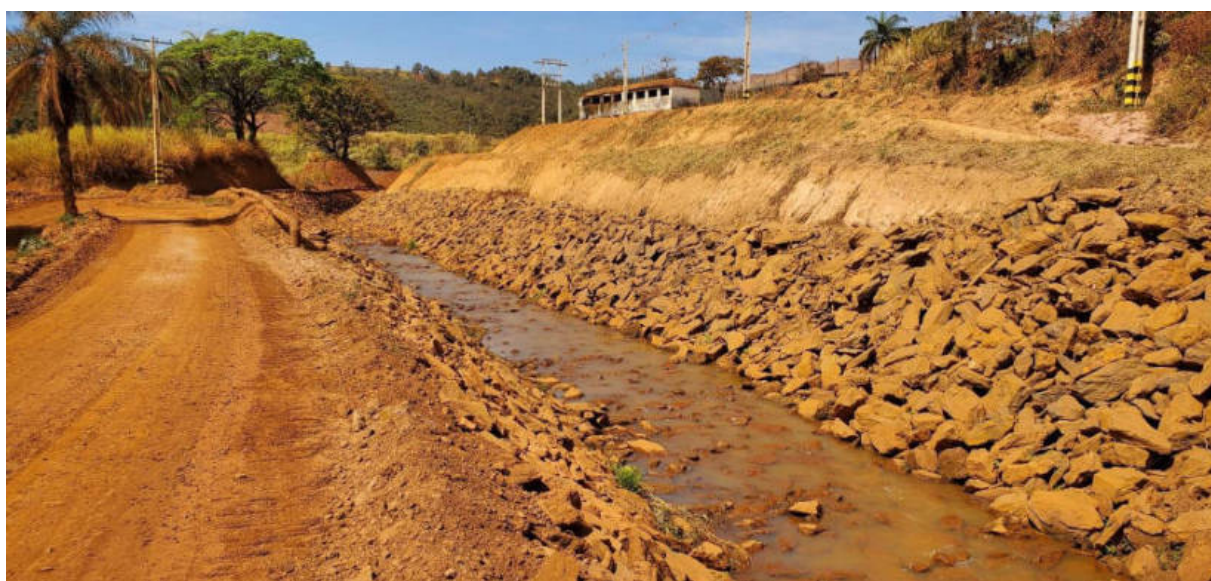
Figura 2 - Vista parcial do canal de desvio
