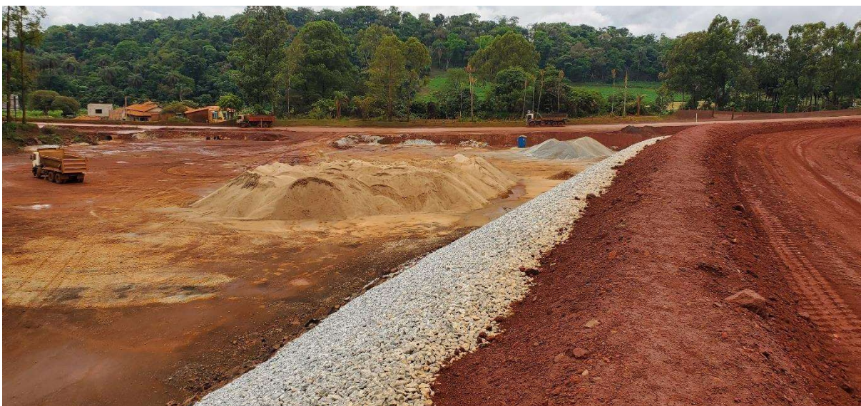
Foto 10 – Material estocado a jusante da estrutura
