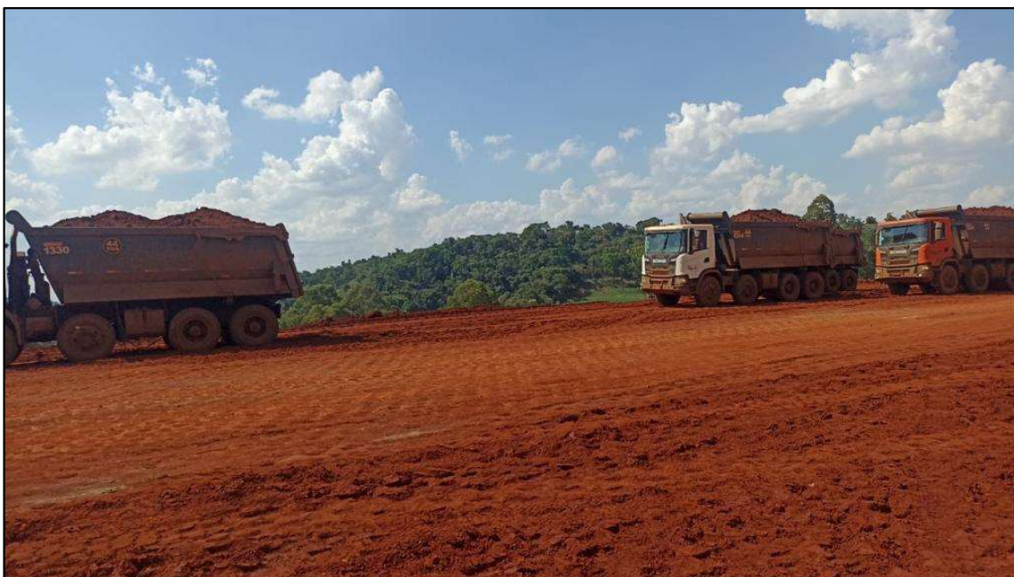
Foto 09 – Vista parcial da execução do aterro controlado. Registro em outubro de 2022.
