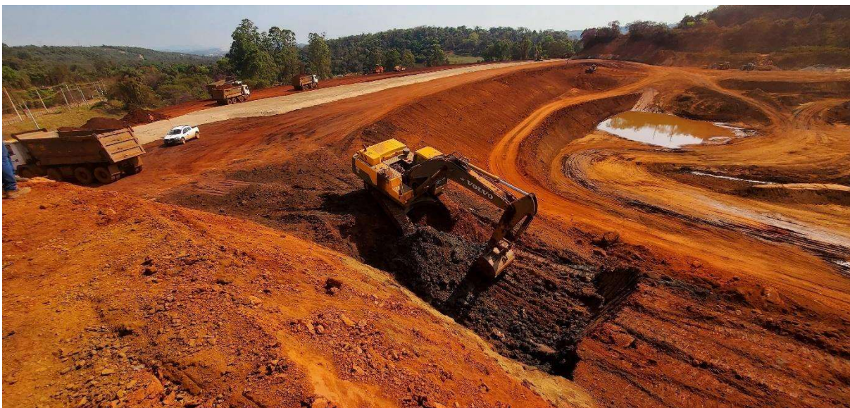
Foto 3 – Vista da escavação executada na ombreira esquerda
