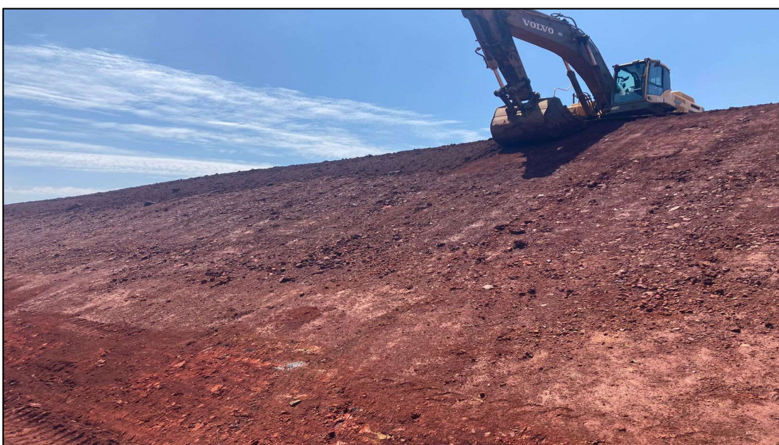
Foto 11 – Regularização dos taludes de jusante para receber a cobertura vegetal. Registro em outubro de 2022.
