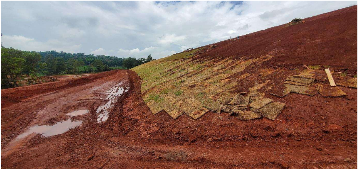
Foto 11 – Plantio de grama no talude da barragem
