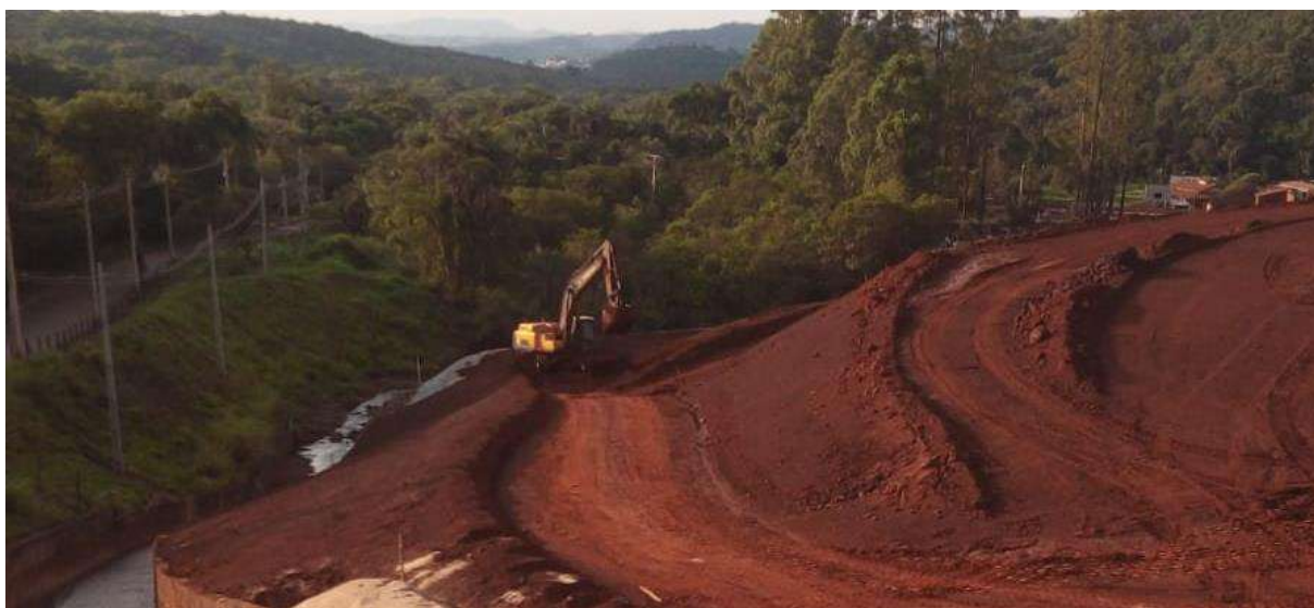
Foto 9 – Regularização do acesso na ombreira esquerda
