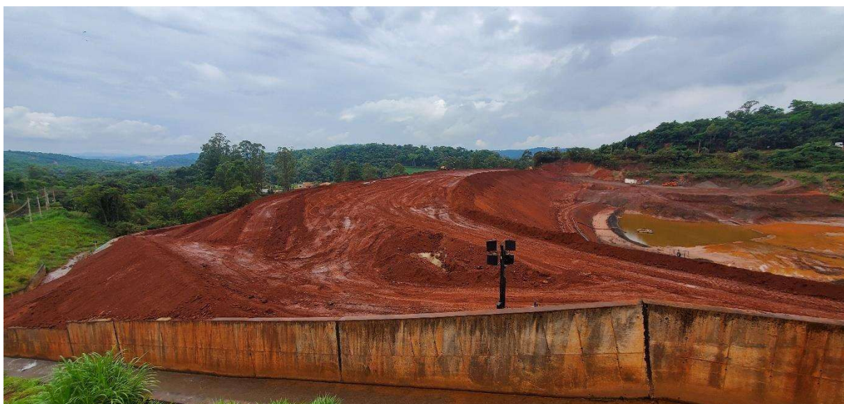
Foto 8 – Aterro do último banco, cota média 839 metros
