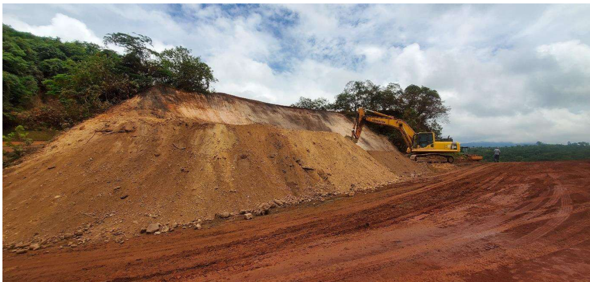
Foto 3 – Vista da escavação executada na ombreira direita
