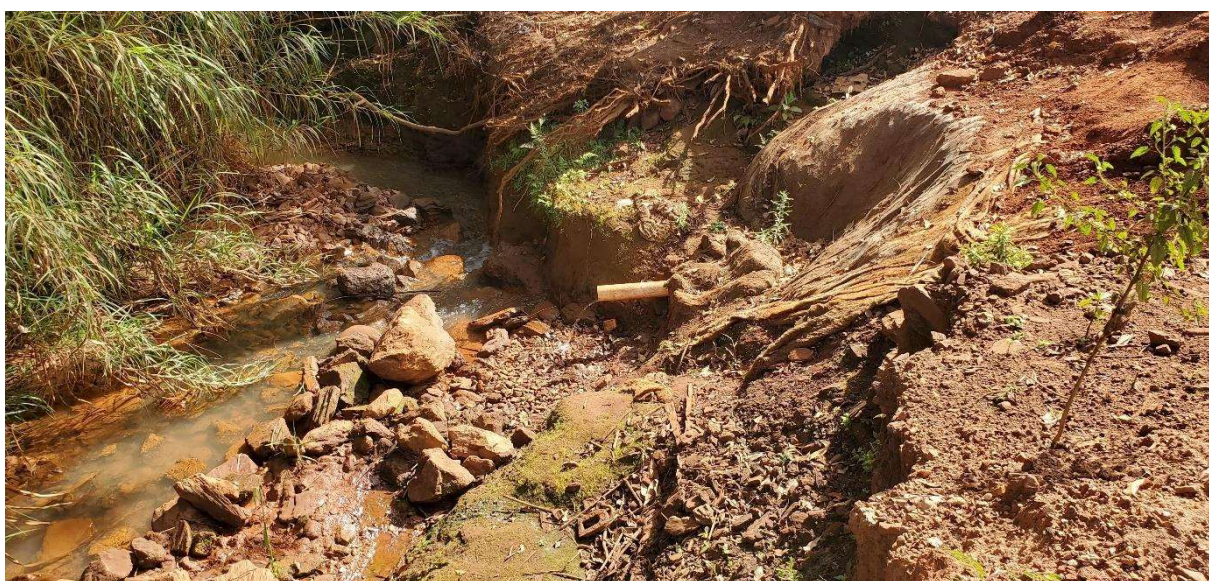
Foto 5 – Local da medição da drenagem interna da estrutura
