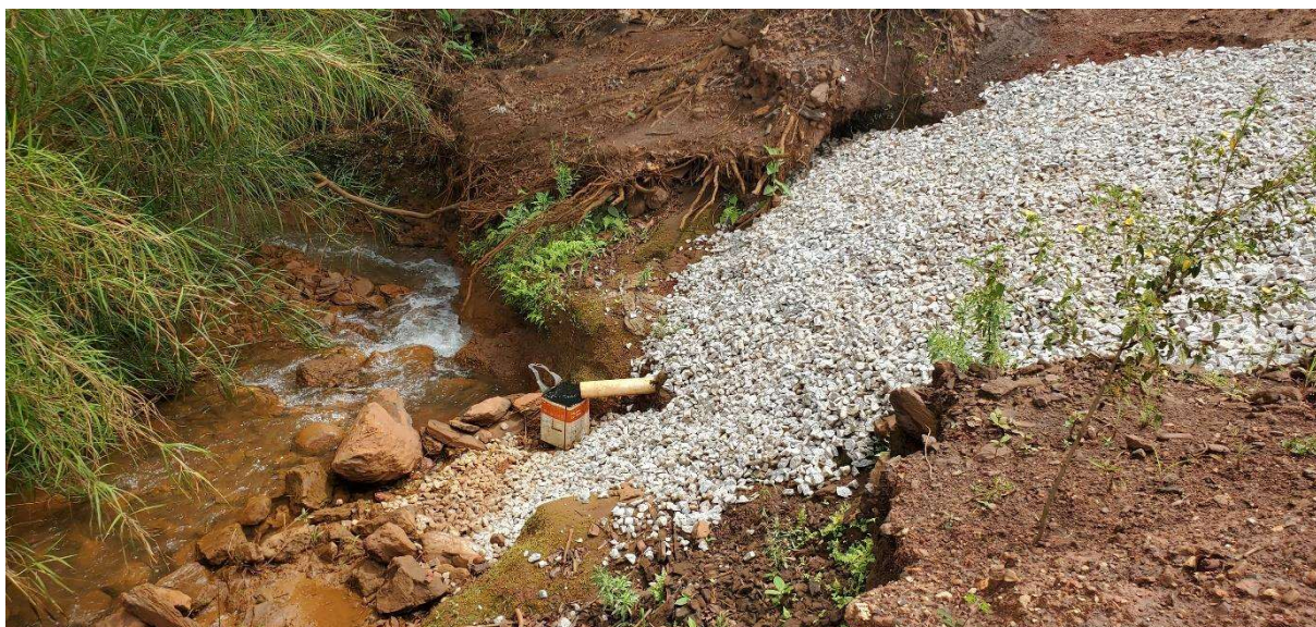
Foto 12 – Local da medição da drenagem interna da estrutura
