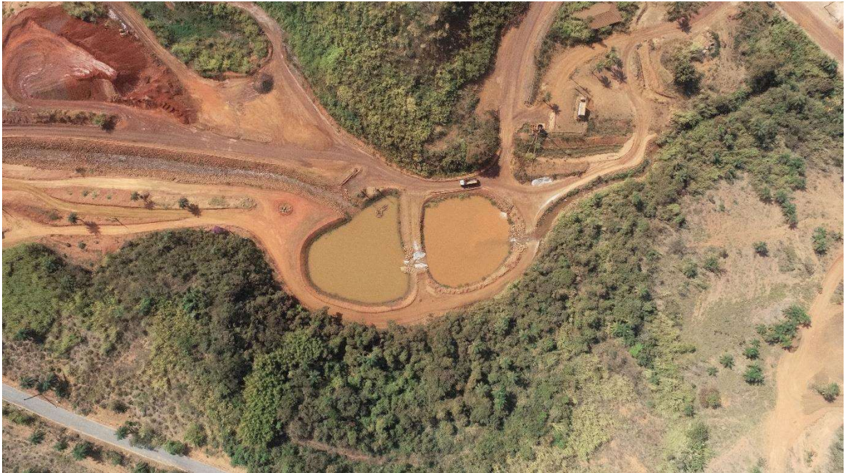
Foto 6 – Vista do sistema de captação e recirculação de água industrial
