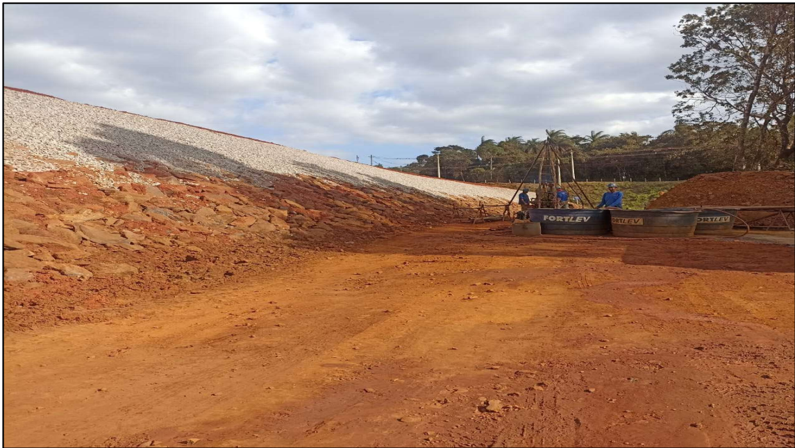
Foto 02 – Investigação geotécnica e instrumentação, notar dreno de fundo e enrocado. Registro em agosto de 2022.
