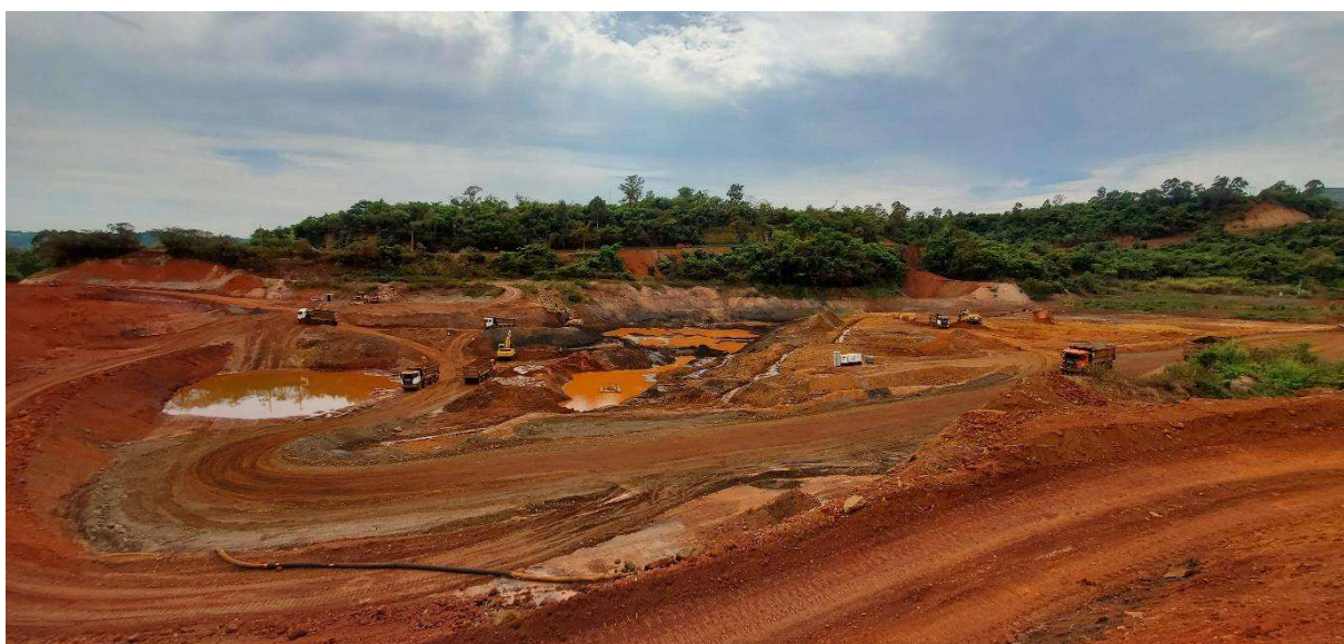
Foto 2 – Vista a montante da barragem, em destaque o desassoreamento do reservatório
