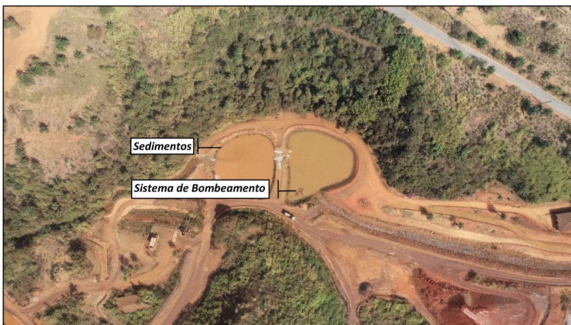
Foto 04 – Vista superior do sistema de captação e recirculação de água industrial. Registro em agosto de 2022.
