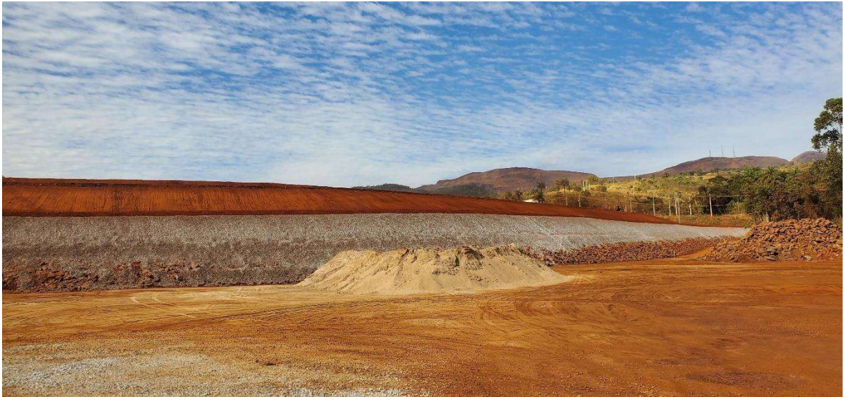
Foto 4 – Material estocado a jusante da estrutura
