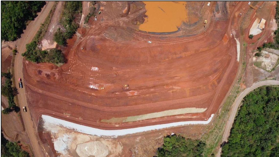
Foto 12 – Vista superior da estrutura, notar revegetação e aterro controlado em andamento. Registro em outubro de 2022.
