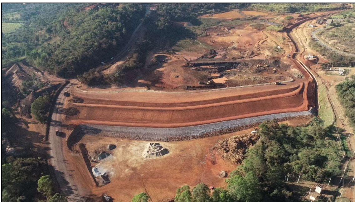
Foto 01 – Vista frontal da estrutura, notar avanço do aterro controlado e remoção dos finos no interior do reservatório. Registro em agosto de 2022.
