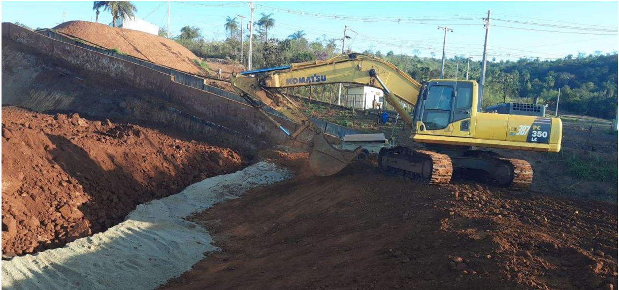
Foto 8 – Detalhe da execução do tapete drenante conectado com o dreno do vertedouro
