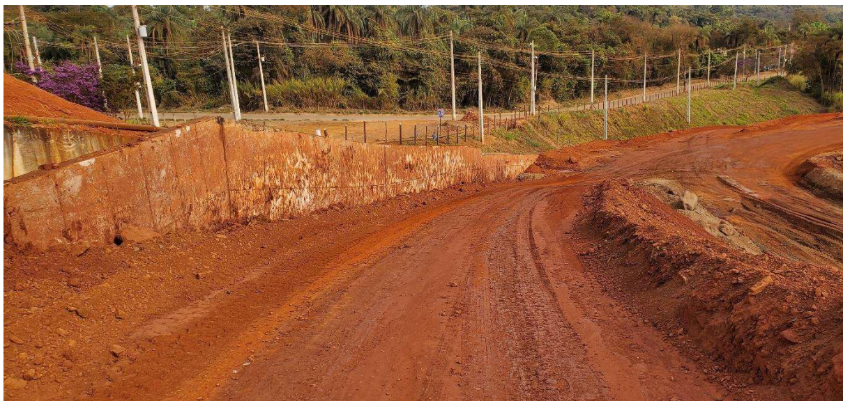
Foto 2 – Detalhe da espera do dreno lateral a parede do vertedouro
