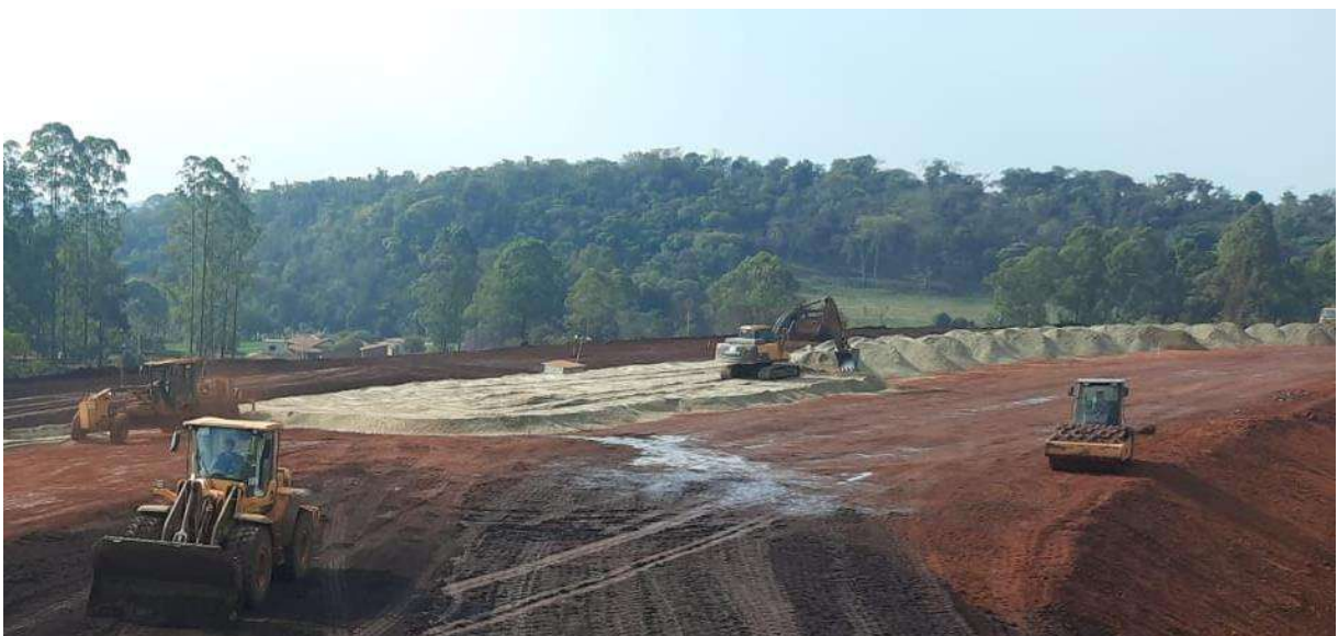
Foto 9 – Execução do filtro vertical/sub-horizontal da estrutura
