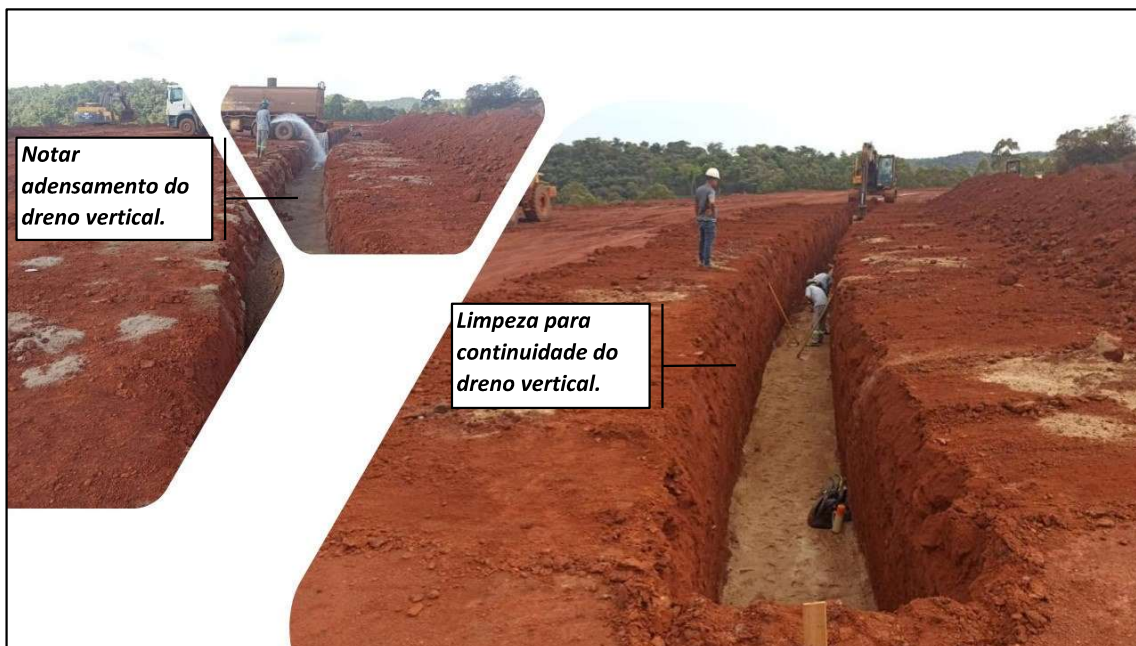
Foto 08 – Execução do dreno vertical. Registro em outubro de 2022.
