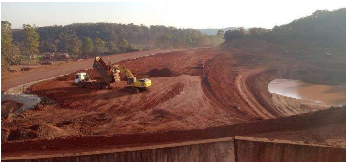
Foto 3 – Início do terceiro banco, cota média 833 metros
