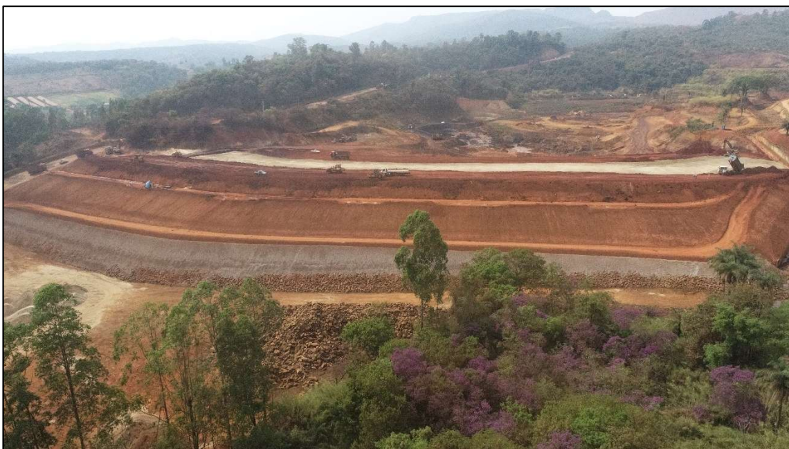
Foto 07 – Vista da estrutura a partir da ombreira esquerda, notar última fase do dreno interno. Registro em setembro de 2022.
