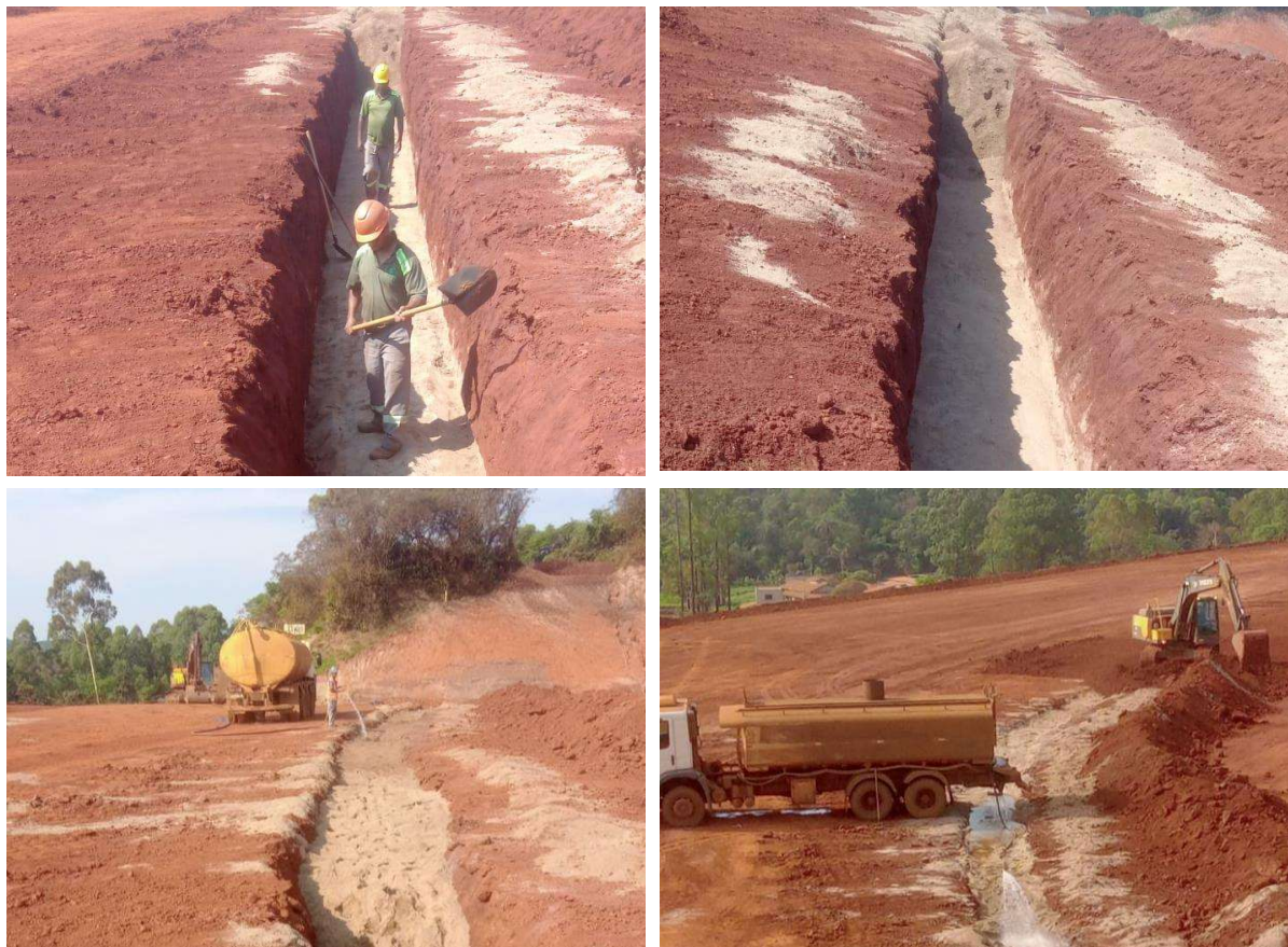
Fotos 4, 5, 6 e 7 – Execução do filtro vertical da estrutura
