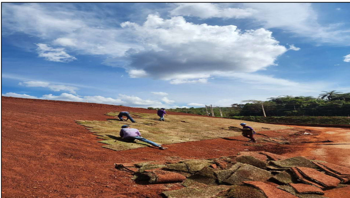
Foto 13 – Detalhe da revegetação dos taludes de jusante. Registro em outubro de 2022.
