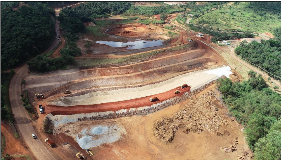
Figura 17 – Vista lateral da estrutura, notar avanço das obras de descaracterização/adequação no intervalo do mês de março.
