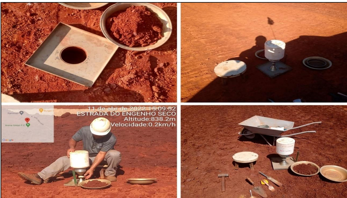
Figura 21 – Ensaios de densidade in situ e controle de compactação. Registros realizados em abril de 2022.
