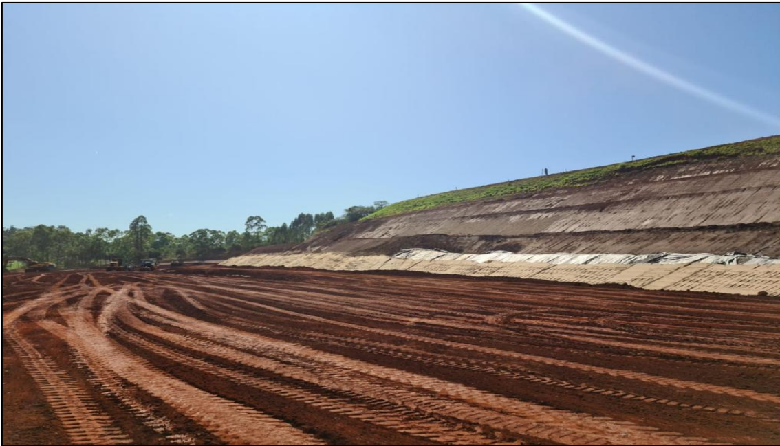
Figura 20 – Vista aproximada do corpo de aterro, notar limite temporário da areia no tapete sub-vertical e taludes de jusante. Registro realizado em abril de 2022.
