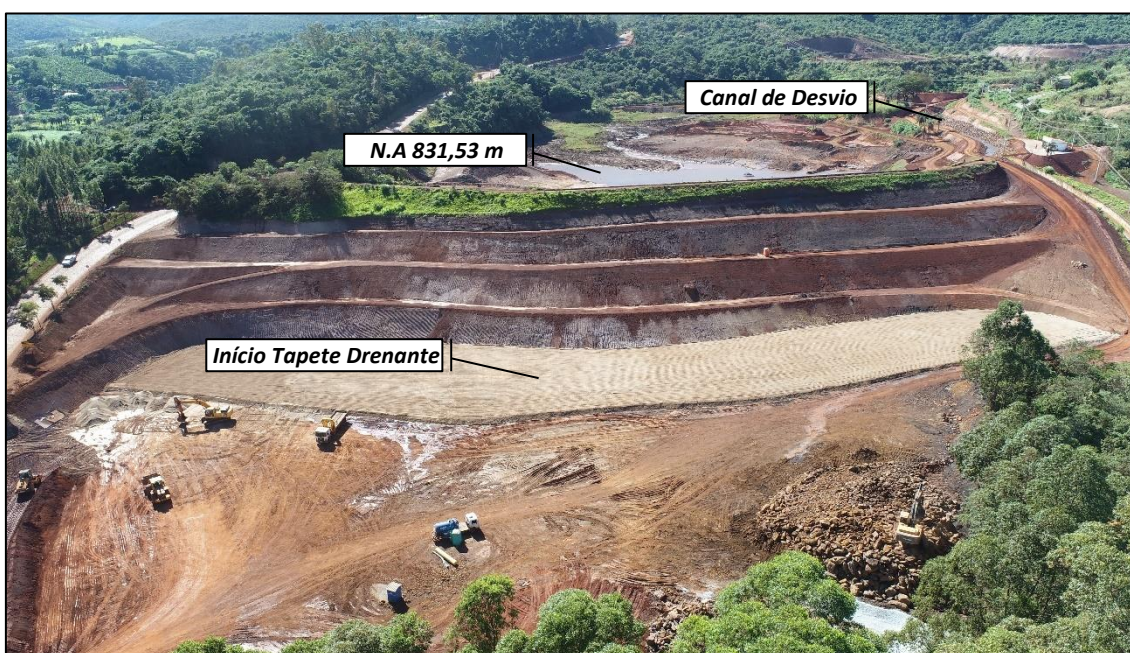
Figura 13 – Vista frontal da estrutura, notar início da execução do tapete drenante, N.A abaixo do nível de projeto e canal de desvio em operação.
