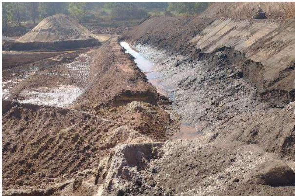
Fotos 3 e 4 – Avanço das escavações, em destaque a saturação da saia do aterro
