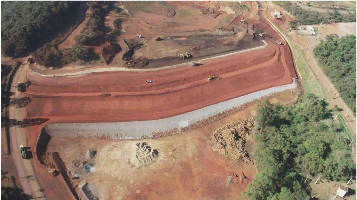
Foto 5 – Início do terceiro banco, cota média 833 metros
