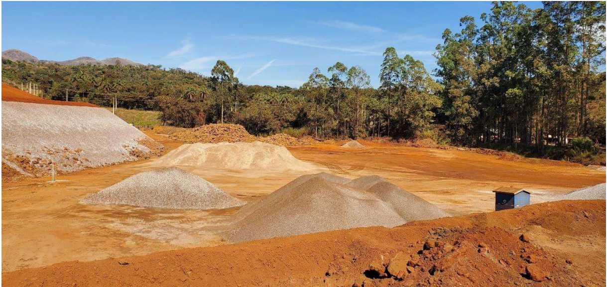
Foto 10 – Material estocado a jusante da estrutura
