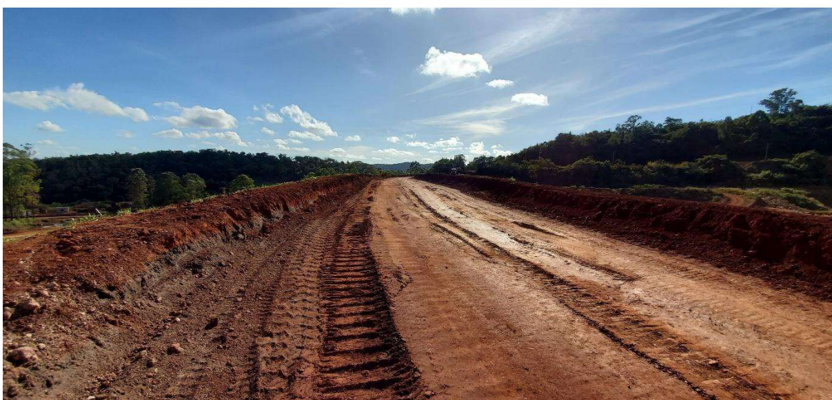
Foto 3 – Vista a montante da barragem, em destaque o NA do reservatório
