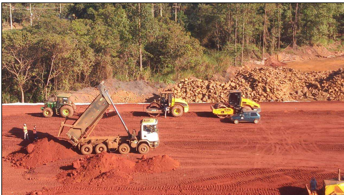
Figura 17 – Vista em detalhe do aterro compactado, notar segunda berma em execução (elevação 830,00 m). Registro em junho de 2022.
