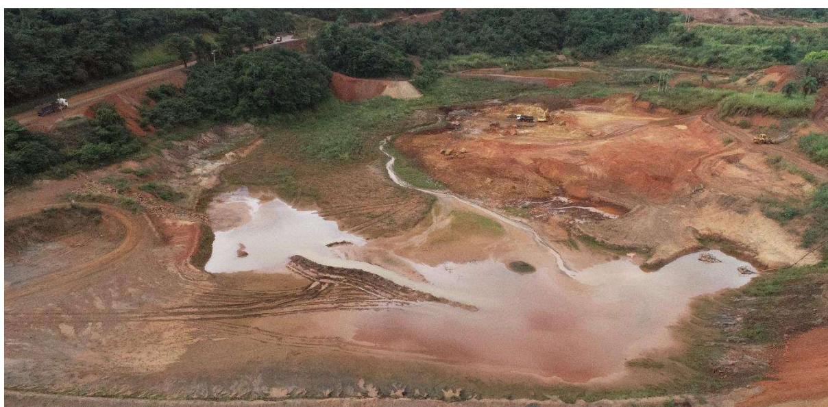
Foto 2 – Vista a montante da barragem – desassoreamento do reservatório
