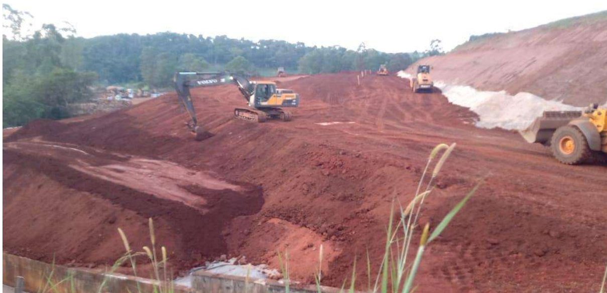
Foto 6 – Execução do acesso na ombreira esquerda
