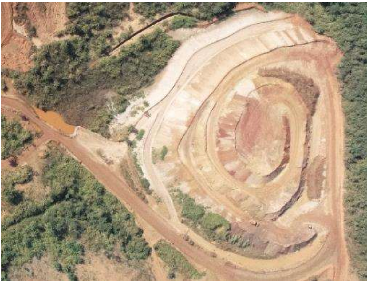
Foto 12 – Vista aérea da Pilha de Limpeza da Barragem B1
