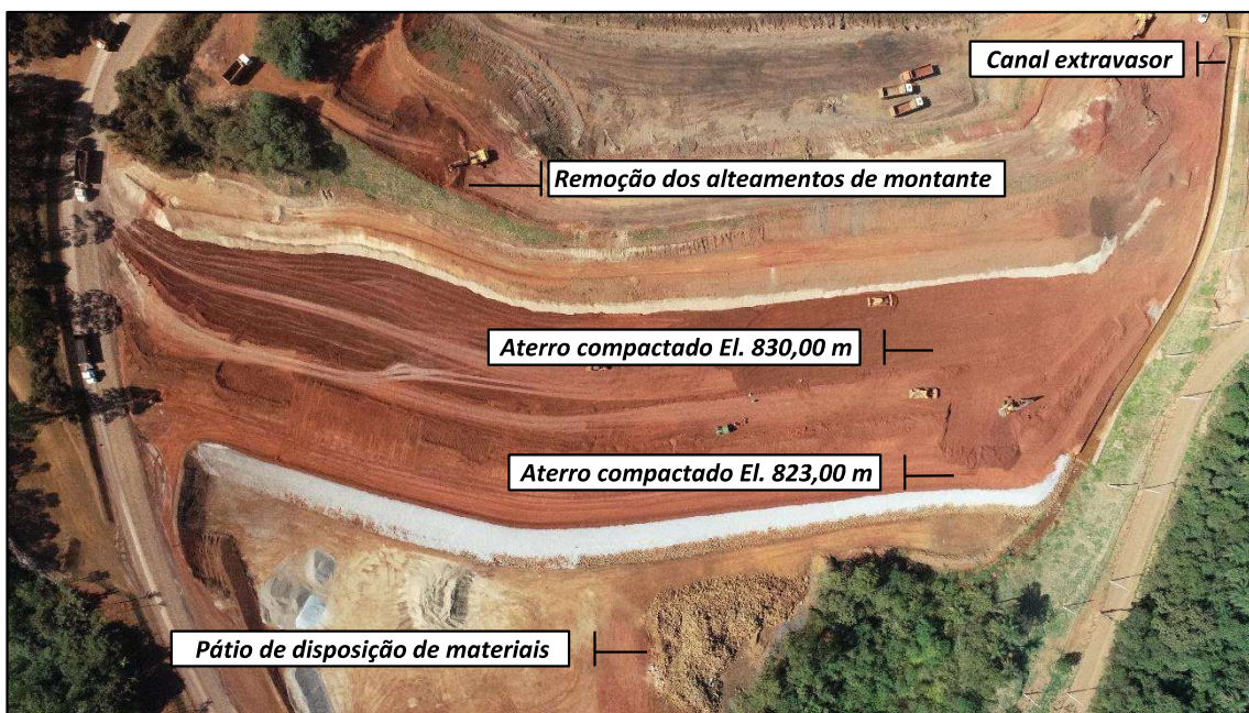
Figura 16 – Vista superior da estrutura. Registro em junho de 2022.
