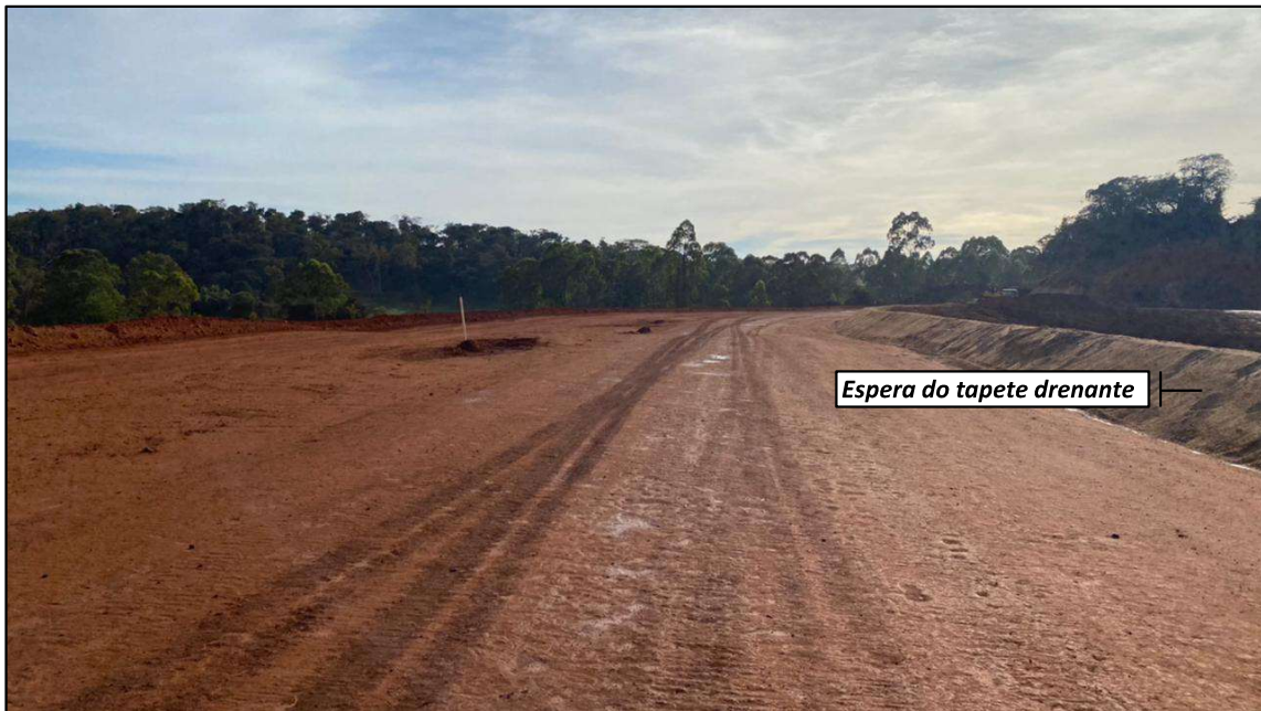
Figura 20 – Vista parcial da crista atual, notar espera do tapete drenante na El. média 833,00 m. Registro em julho de 2022.
