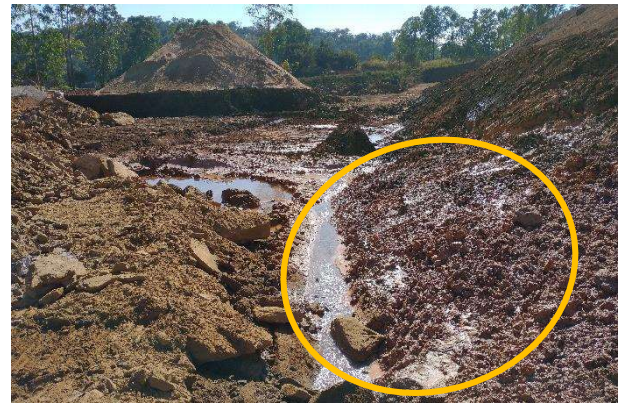
Fotos 3 e 4 – Avanço das escavações, em destaque a saturação da saia do aterro
