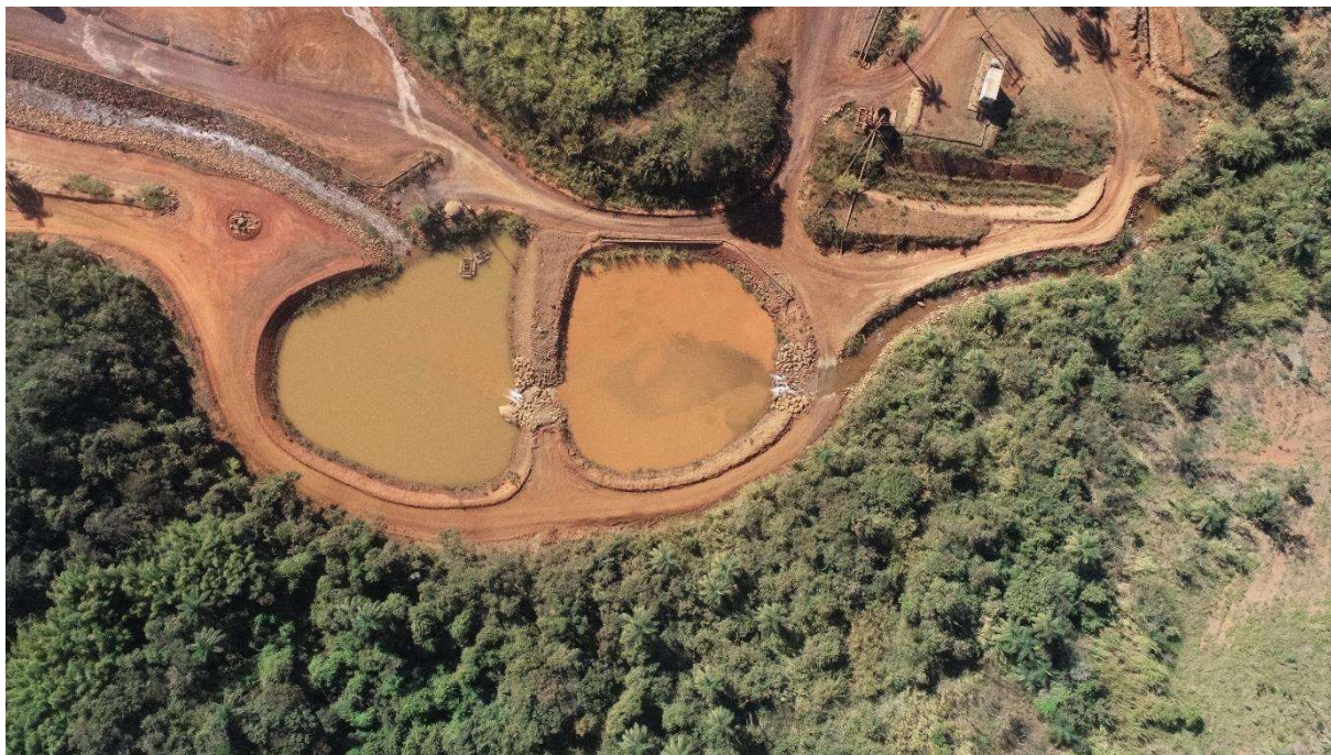
Foto 7 – Vista do sistema de captação e recirculação de água industrial
