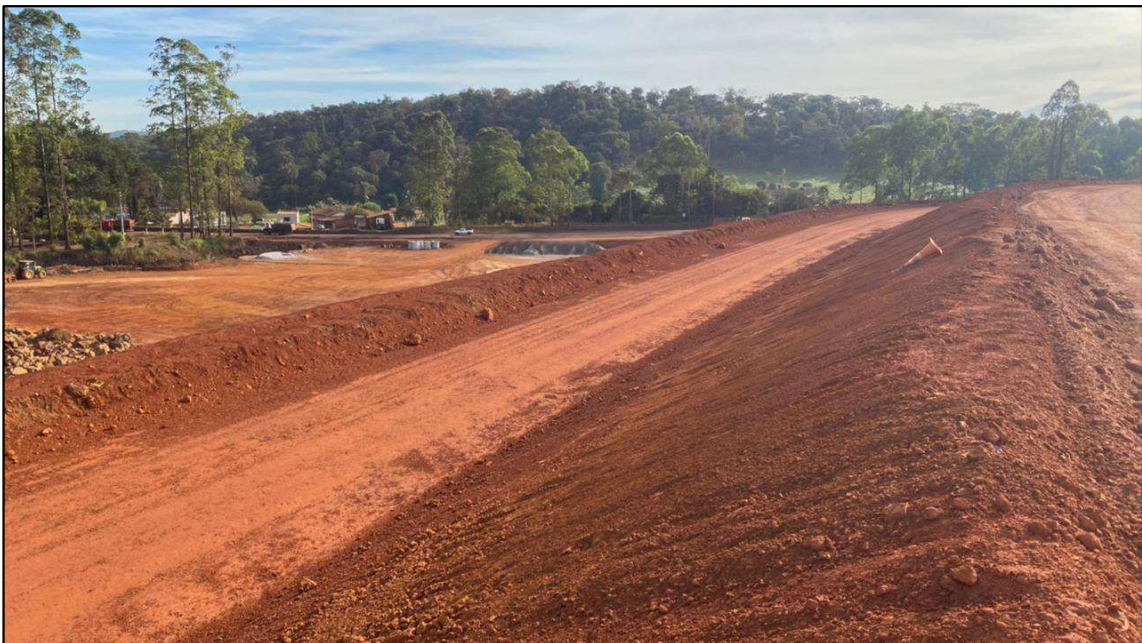
Figura 21 – Regularização longitudinal e transversal das bermas para implantação de obras civis. Registro em julho de 2022.
