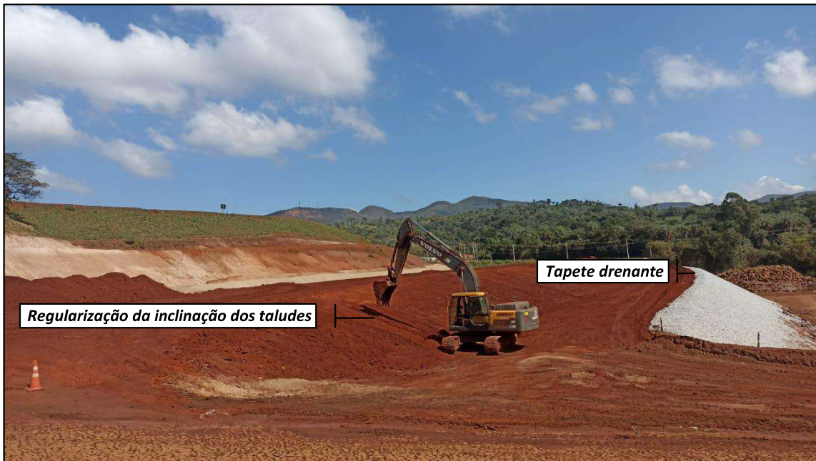
Figura 14 – Vista da estrutura a partir da ombreira esquerda. Registro em maio de 2022.
