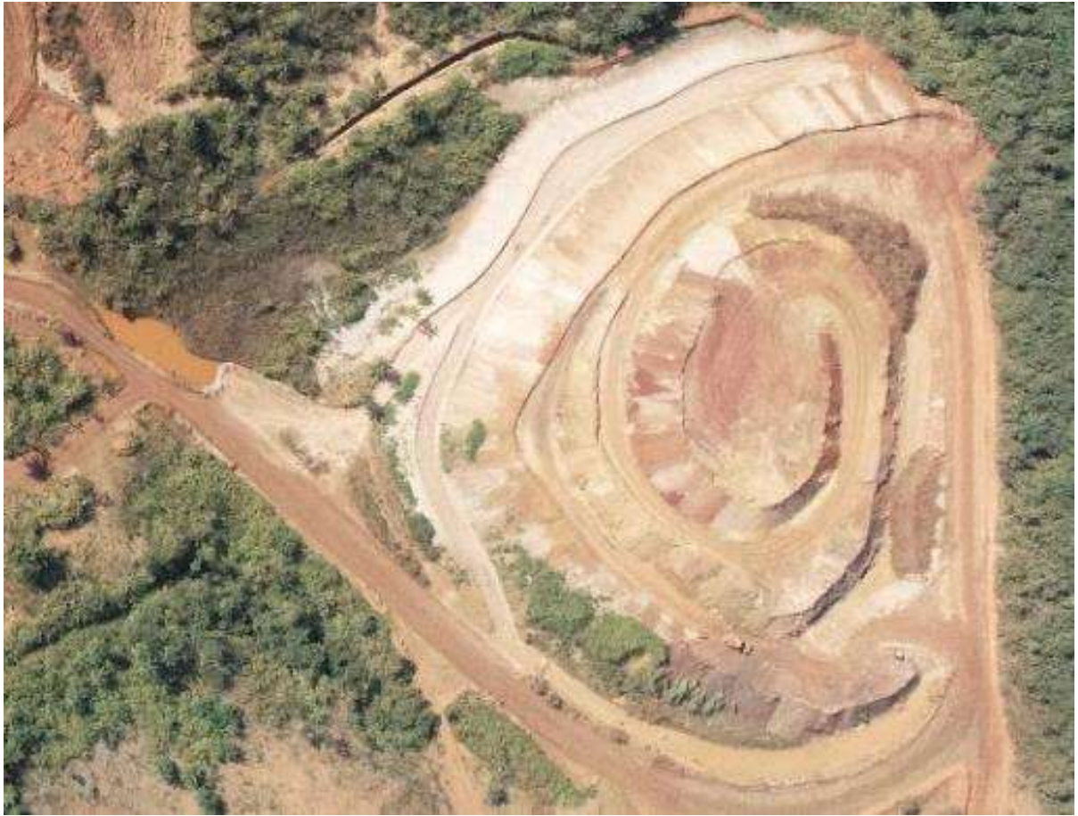
Foto 8 – Vista aérea da Pilha de Limpeza da Barragem B1
