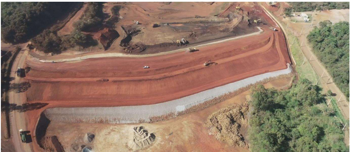
Foto 8 – Início do terceiro banco, cota média 833 metros
