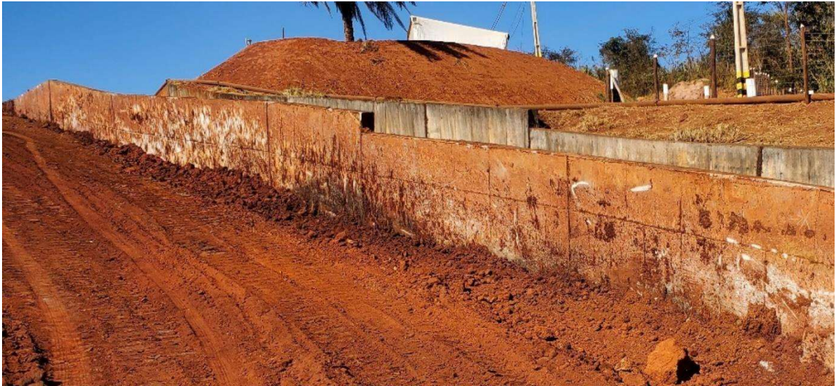
Foto 3 – Detalhe da escavação próxima a parede do vertedouro
