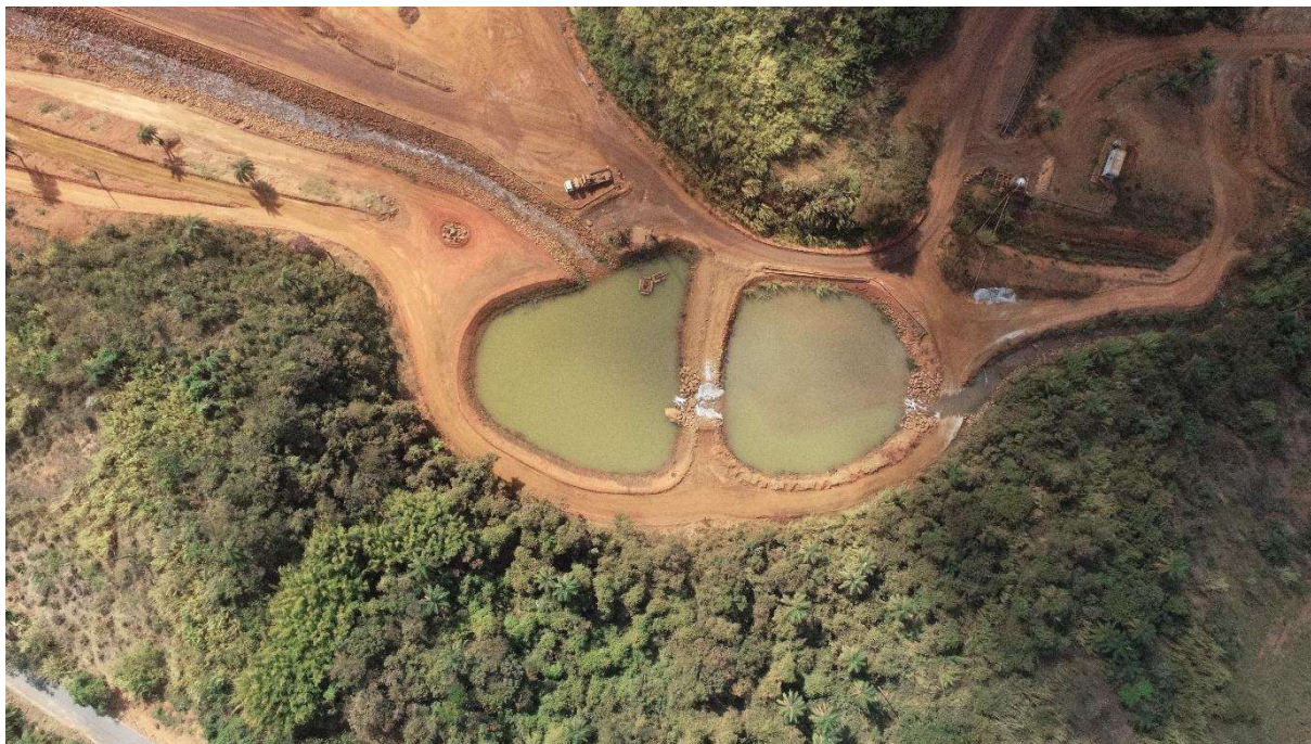
Foto 11 – Vista do sistema de captação e recirculação de água industrial
