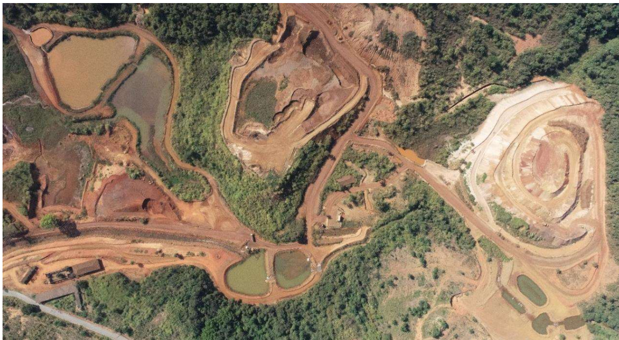
Foto 7 – Vista do sistema de captação e recirculação de água industrial
