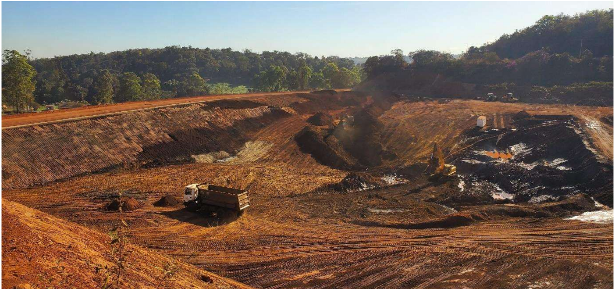
Foto 2 – Vista da escavação de montante da barragem
