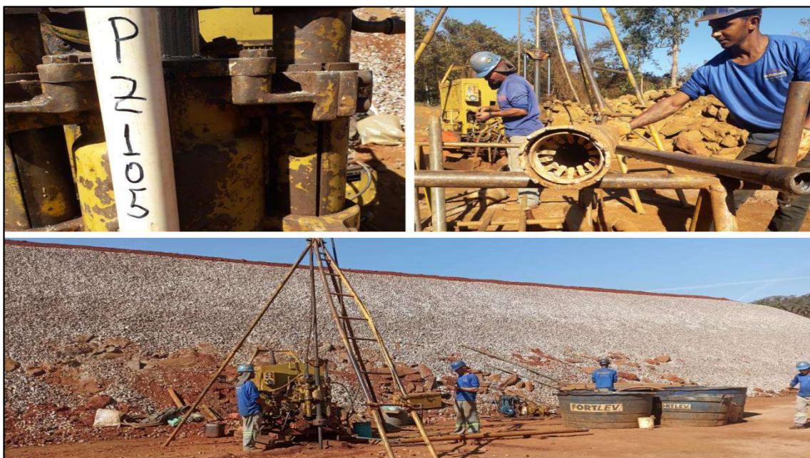
Figura 22 – Campanha de investigação geotécnica e instrumentação DS001571-R0 .
