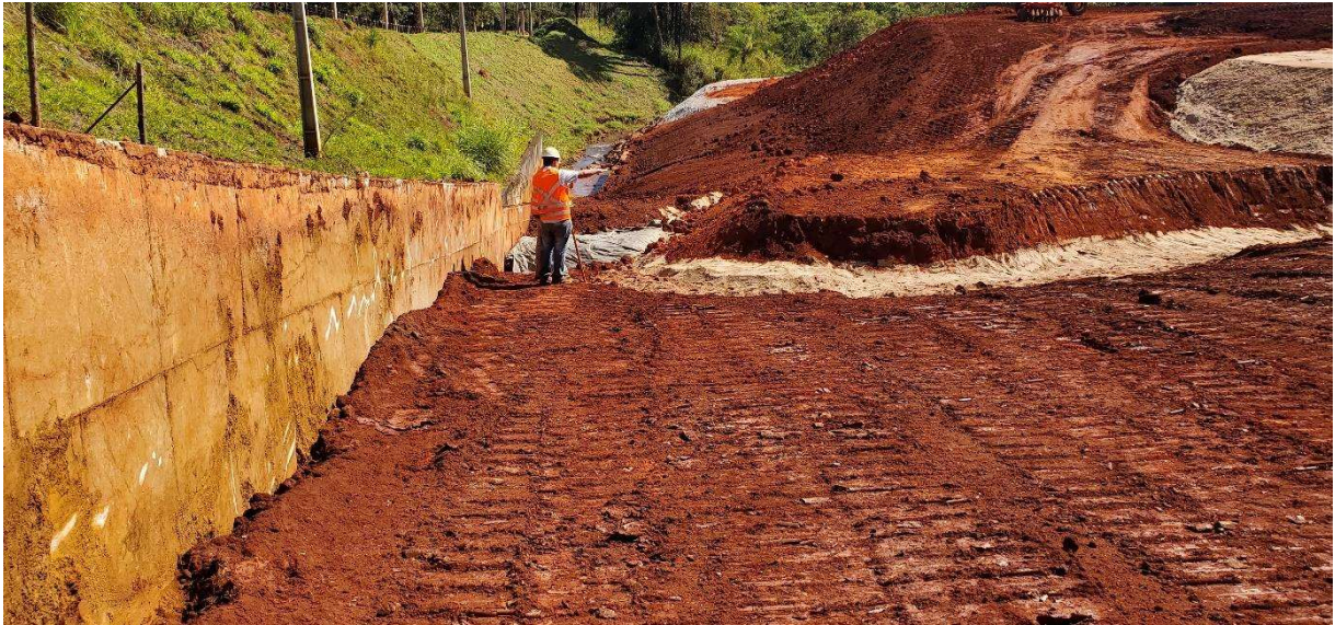
Foto 5 – Detalhe da espera do dreno lateral a parede do vertedouro
