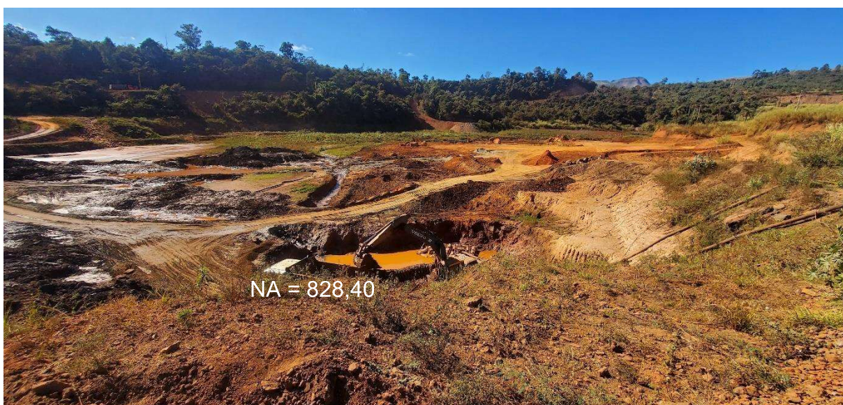
Foto 1 – Vista a montante da barragem, em destaque o NA do reservatório
