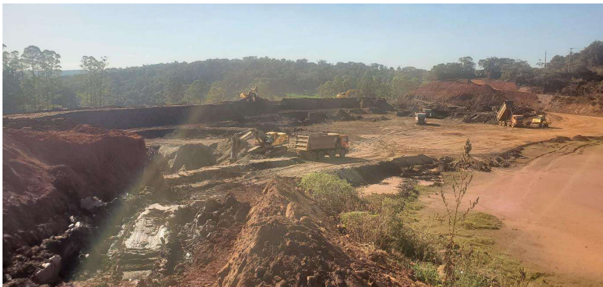
Foto 2 – Vista de montante da barragem, em destaque o coroamento da estrutura
