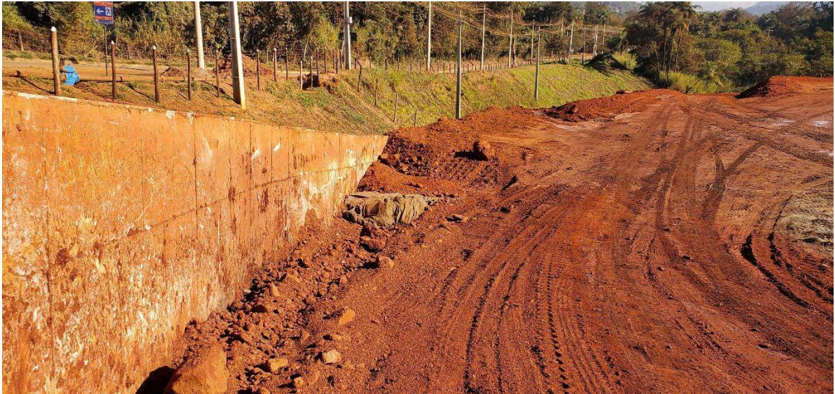
Foto 7 – Detalhe da espera do dreno lateral a parede do vertedouro
