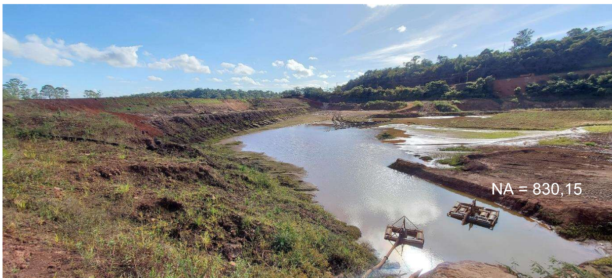
Foto 1 – Vista a montante da barragem, em destaque o NA do reservatório
