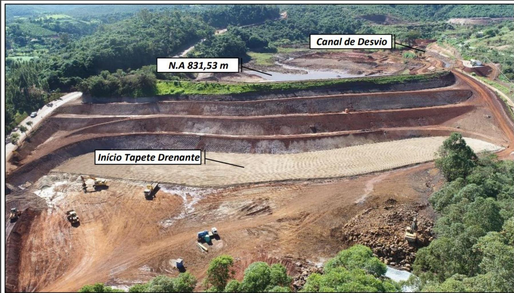
Vista frontal da estrutura, notar início da execução do tapete drenante, N.A abaixo do nível de projeto e canal de desvio em operação.
