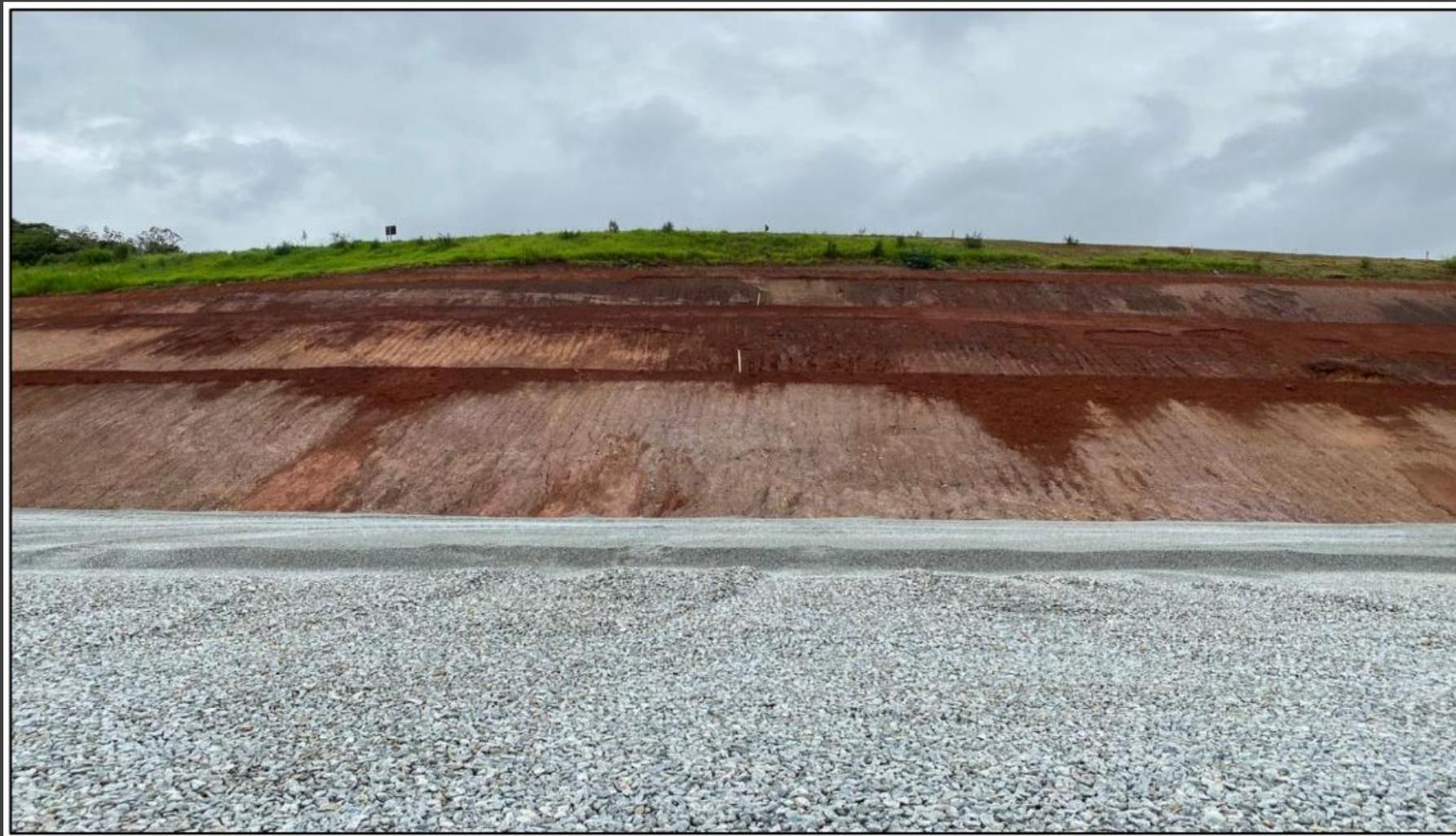
Vista aproximada da transição entre a brita 0 e 2, notar ausência de proteção vegetal dos taludes de jusante, em função das obras de descaracterização/adequação. Registro realizado no mês de dezembro de 2021.
