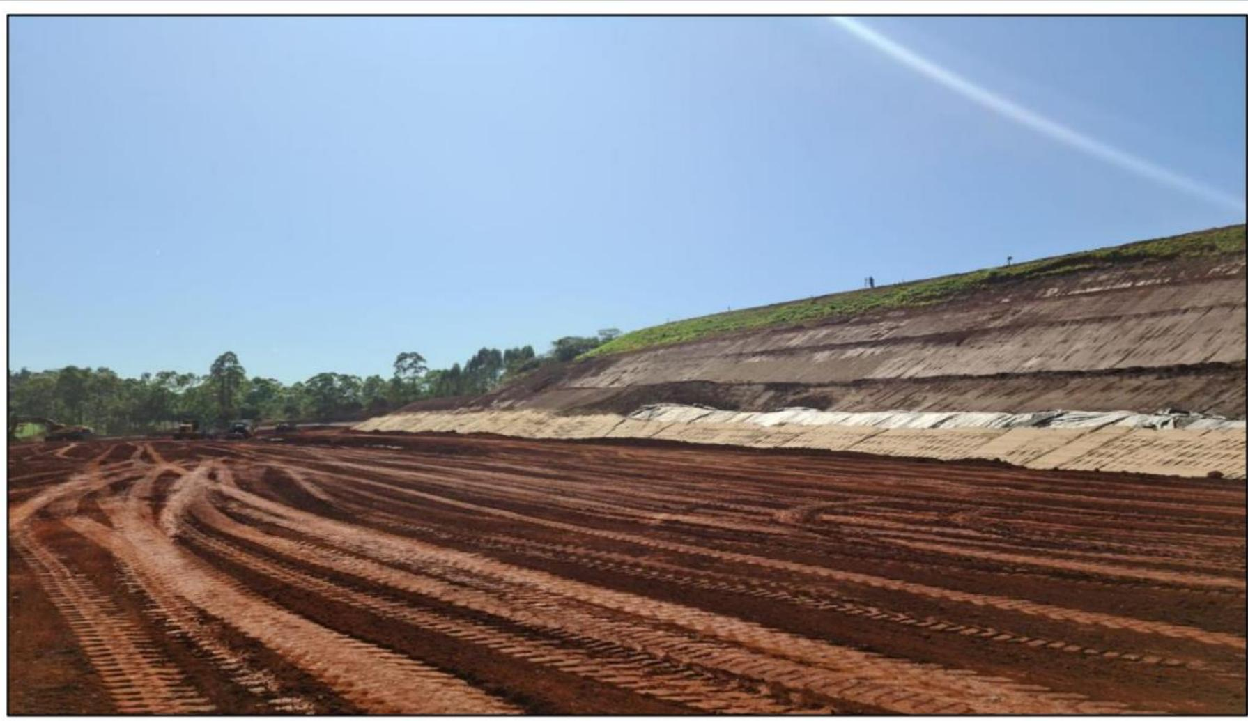
Vista do corpo de aterro, notar limite temporário da areia no tapete sub-horizontal e taludes de jusante. Registro realizado em abril de 2022.
