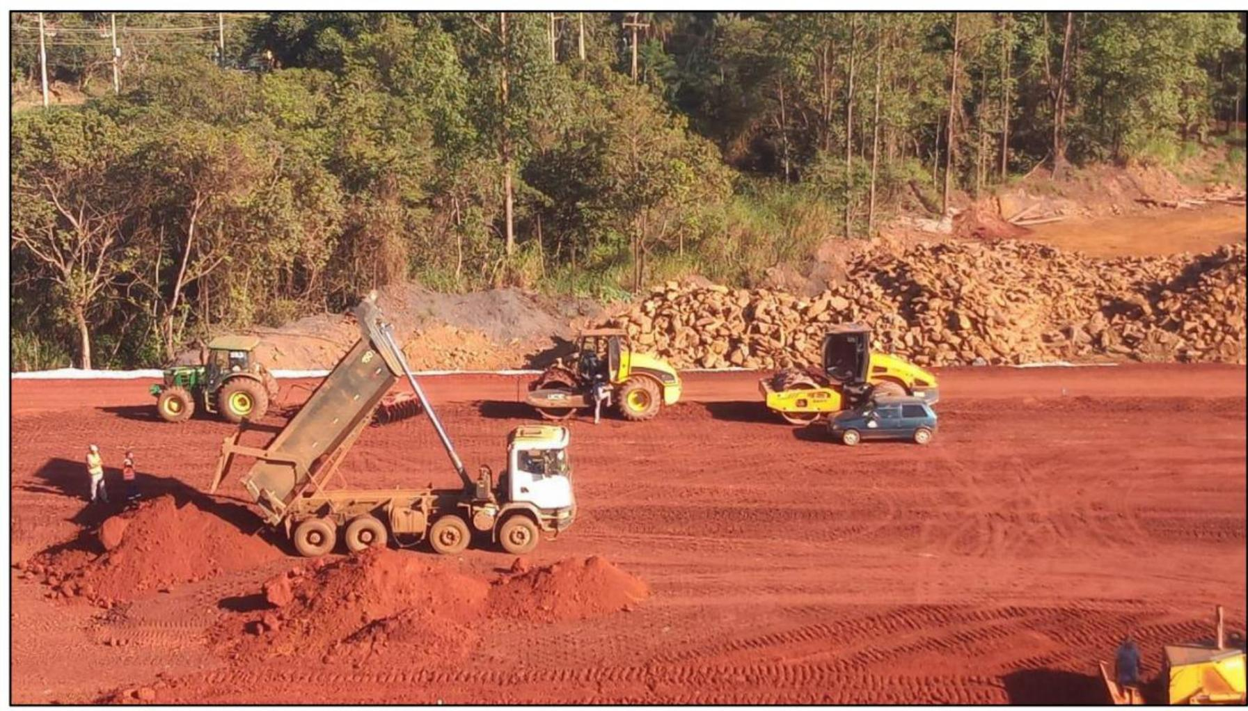
Vista em detalhe do aterro compactado, notar segunda berma em execução (elevação 830,00 m). Registro em junho de 2022.
