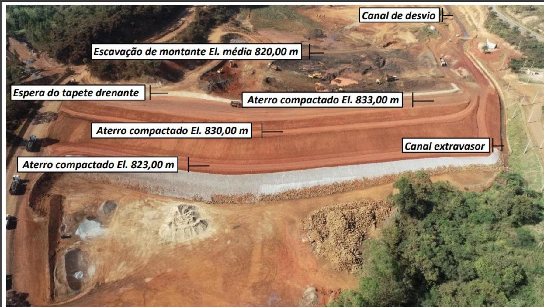
Vista geral da estrutura, notar avanço do processo de descaracterização e adequação.
